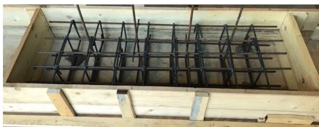
Fig.9 – Armatura del cordolo in c.a.
