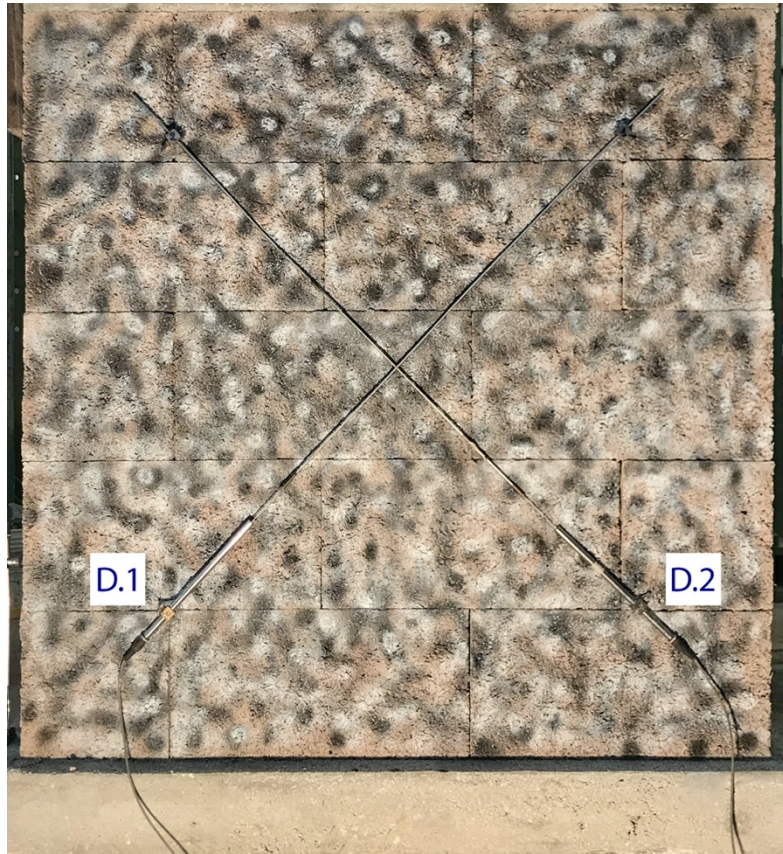
Fig.37 – Predisposizione dei trasduttori D.1 e D.2
