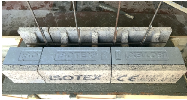
Fig.10 – Armatura di ripresa
