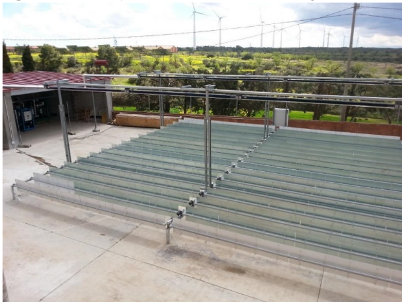
Figura 5: Campo a concentrazione solare con lenti lineari di Fresnel. Per l'immagine si faccia riferimento a [F1].
