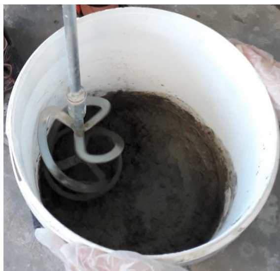
Figura 6 - Miscelazione con miscelatore elettrico
