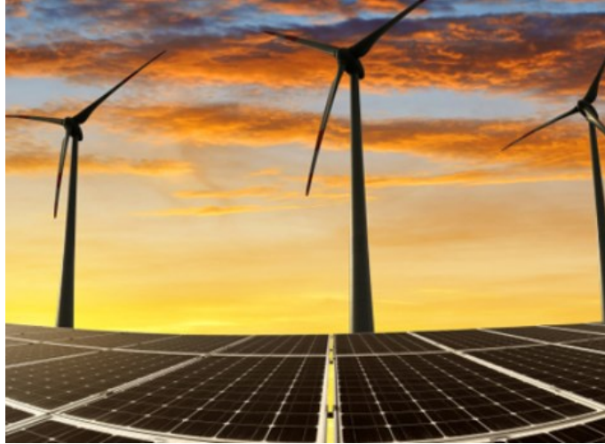
Figura 2.2.1 Pannelli fotovoltaici e turbine eoliche
