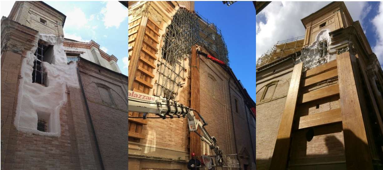
Figura 67 Sistema di cattura e consolidamento delle murature
