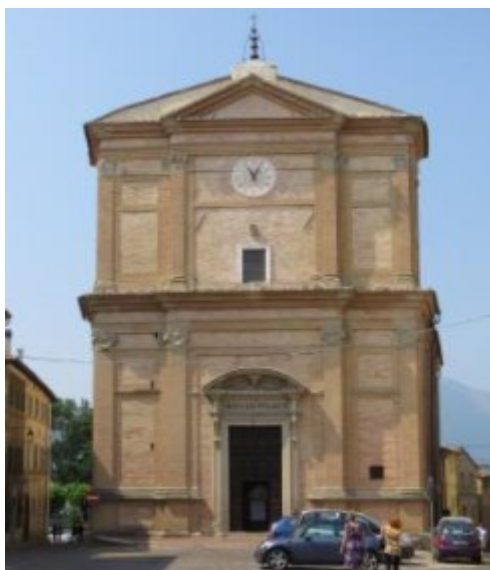
Figura 52 Facciata della Chiesa di Santa Maria in Via, prima del terremoto del 2016
