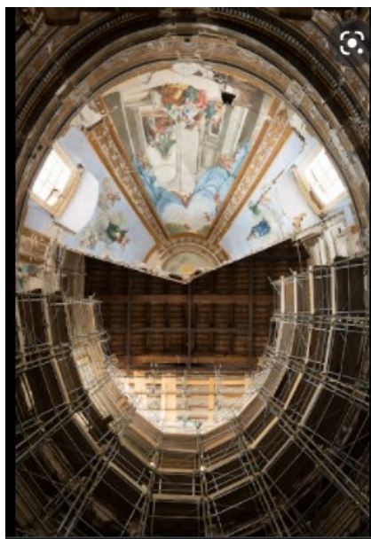
Figura 74 Sistema di tubi giunti e copertura provvisoria
