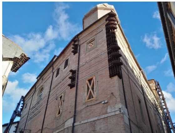
Figura 71 Sistema di deviatori
