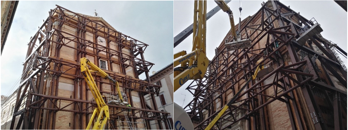
Figura 70 Sistema di controventi
