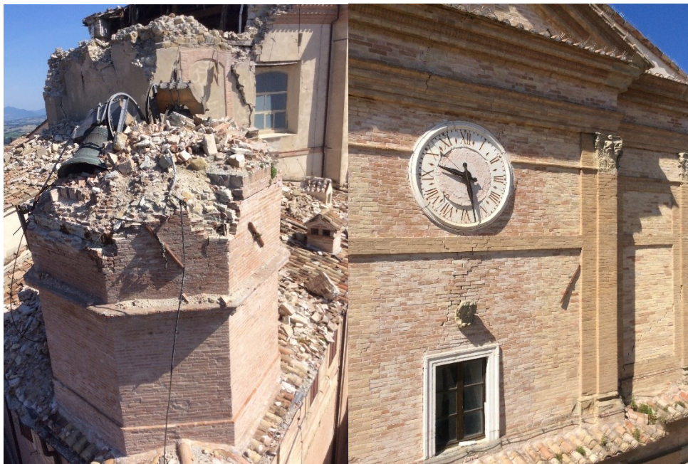
Figura 57 Rovine della cella campanaria e particolare dell' orologio della facciata
