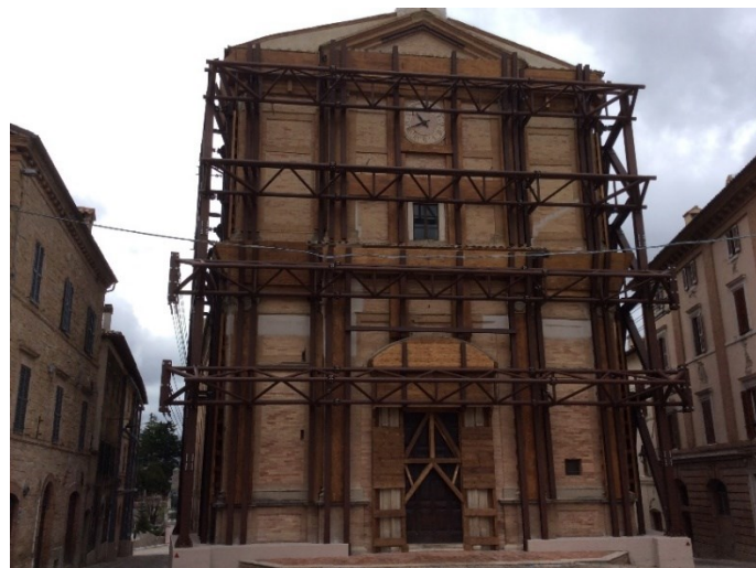
Figura 69 Messa in sicurezza della facciata
