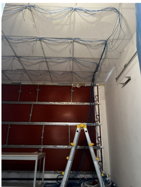
Figura 11: Installazione Termocoppie T
