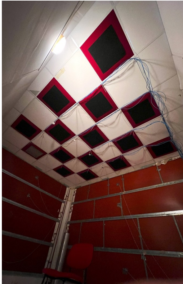
Figura 51: Test Room con Pannelli Innovativi installati
