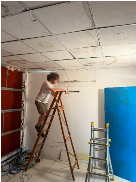
Figura 49: Foto Installazione Pannelli Standard
