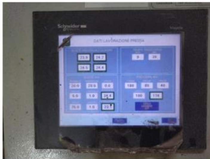
Settaggio pressa “ciclo leggeri off” alta pressione.
