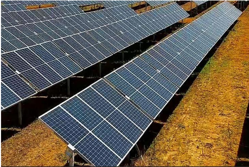
Figura 4.13 Esempio di Tracker monoassiali e monofacciali
