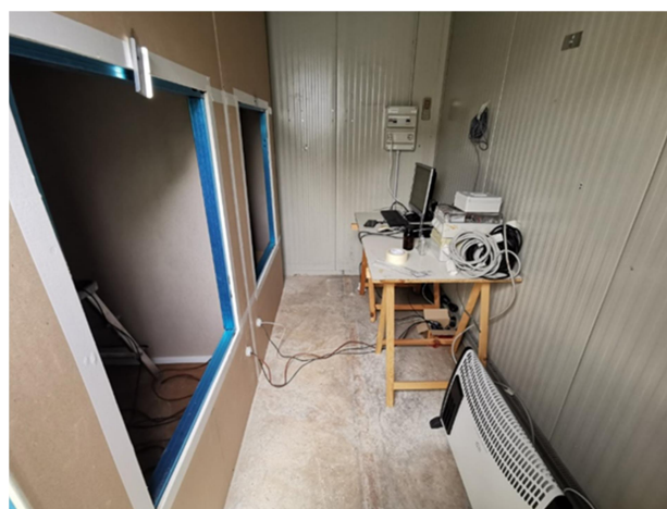
Figura 74 – Allestimento sistema monitoraggio
