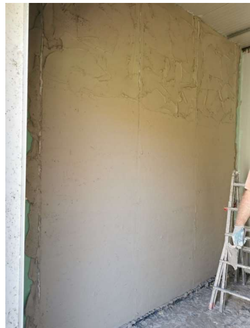
Figura 70 – Applicazione calce storica
