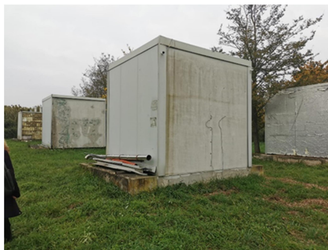
Figura 66 – Prefabbricato oggetto di studio
