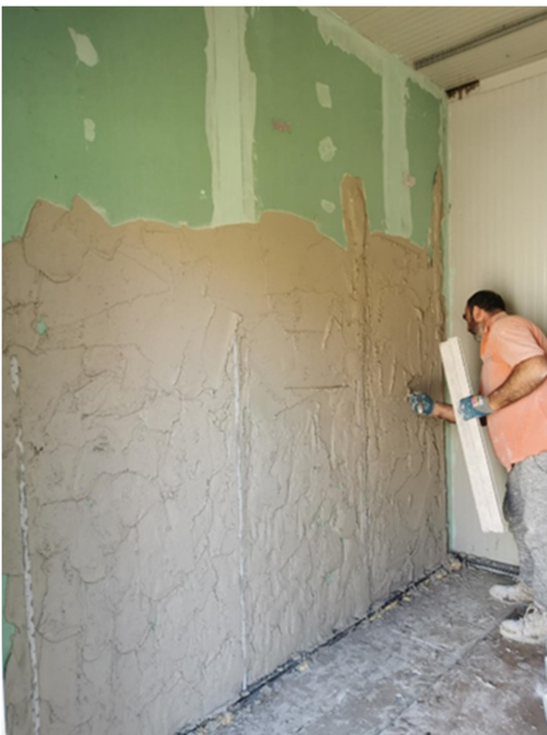
Figura 69 – Applicazione calce storica
