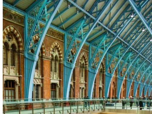
Figura 10-Particolare dell'attacco tra la volta a struttura metallica e l'edificio in muratura
