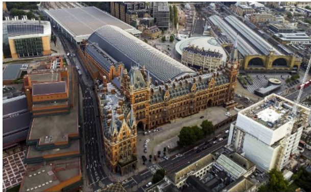
Figura 11- Veduta aerea della stazione
