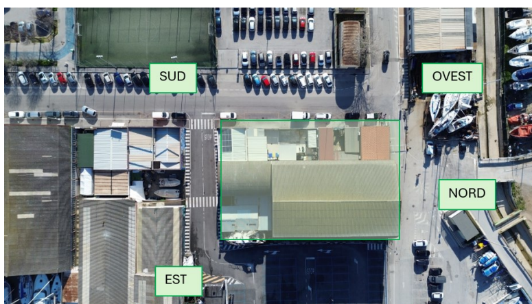
Figura 79- Vista con il drone dall’alto
