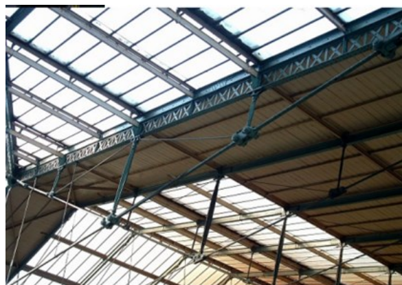
Figura 148-149 - Vista interna della stazione Nord con particolare della trave reticolare
