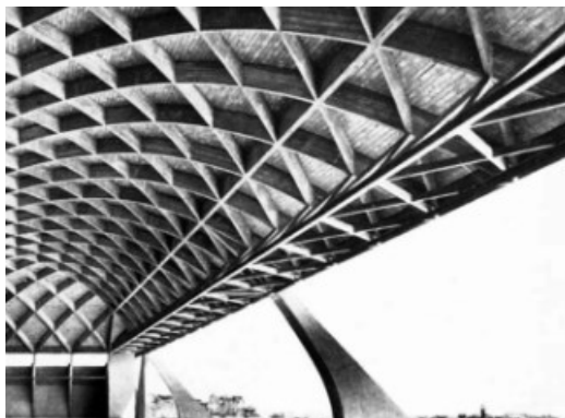
Figura 15- Particolare della trave reticolare di bordo sul lato apribile
