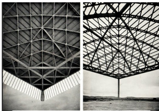
Figura 23- Particolare della struttura a elementi prefabbricati in c.a. in uno dei quattro angoli.
