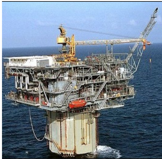
Figura 3.9: Piattaforma offshore “SPAR”.
