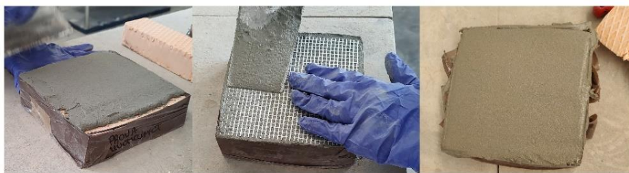
Figura 34: Stesura di prova Mapetherm
