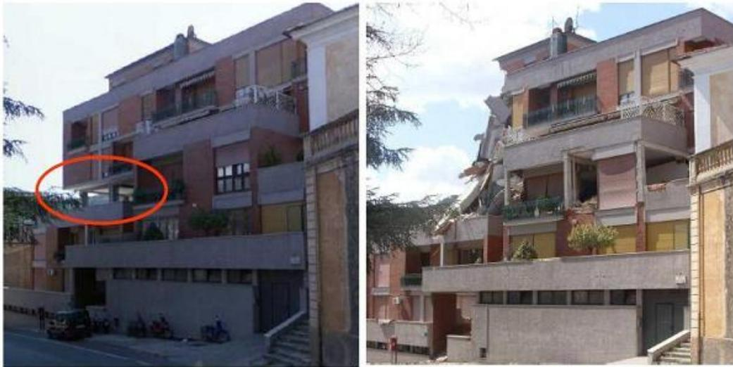
**Figura 1.1:** Esempio di collasso dovuto a cedimento del piano sofficce (Aquila, 2009).
