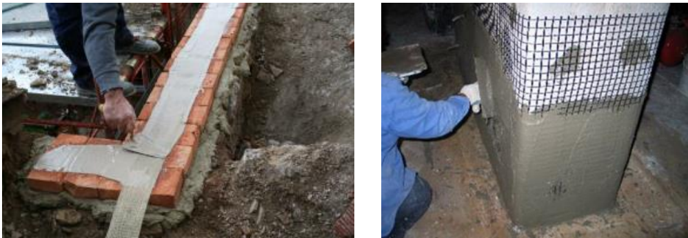
Figura 18 – Cordolo sommitale realizzato con tessuti a base di reti di acciaio (a sinistra); Confinamento di pilastro in muratura con rete di vetro A.R. (a destra). [4]
