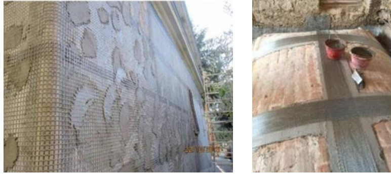
Figura 17 – Rinforzo di pannelli murari con rete di basalto (a sinistra); Applicazione di fasce di tessuto metallico galvanizzato unidirezionale e malta per il rinforzo estradossale di volte murarie (a destra). [4]
