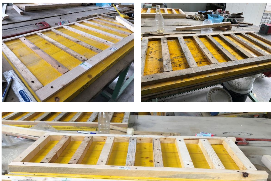
Figura 21 - Realizzazione casseri con altezze di 10, 20 e 30 mm.
