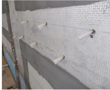
Figura 20 - Rinforzo di nodi travi-pilastro con tessuto metallico unidirezionale e malta (a sinistra); Rinforzo antiribaltamento di pareti con rete di fibra di vetro, malta e fiocchi di fibra di vetro (a destra).
