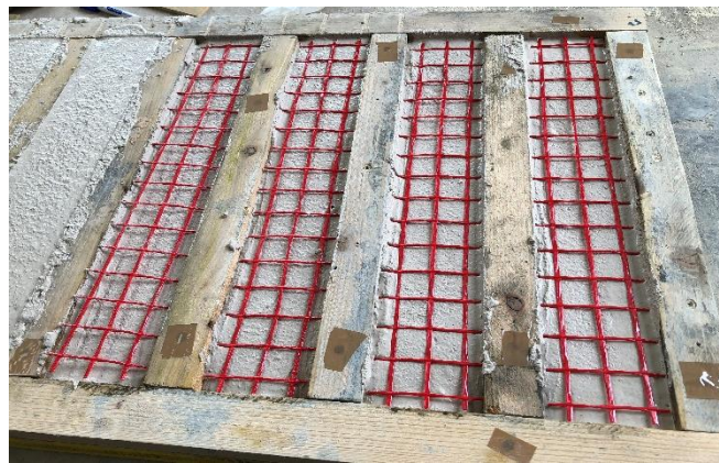
Figura 22 - Applicazione del primo strato di malta e della rete.
