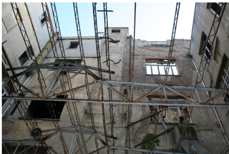
Figura 2..1 - Setto murario rimasto in piedi
