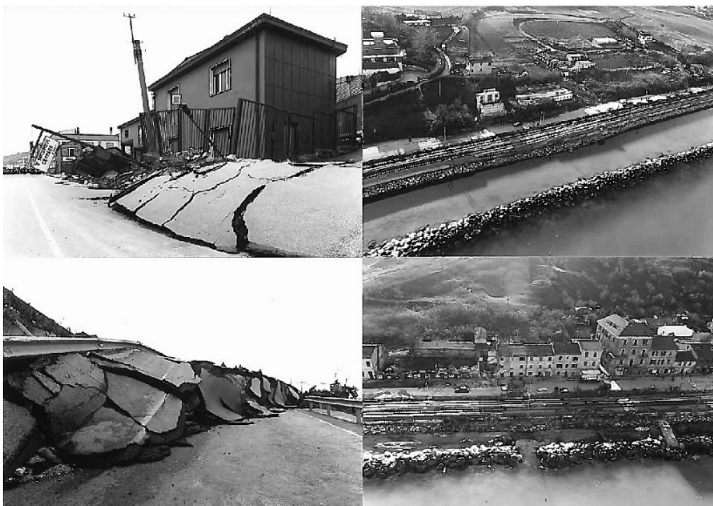
Figura 1.3 - Foto storiche di Palombella dopo la frana (dal sito del Comune di Ancona)
