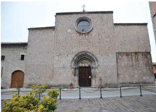
Figura 6.4 Foto prospetto ovest
