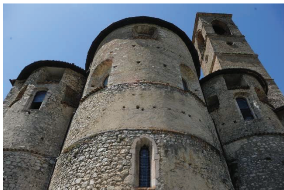
Figura 6.6 Foto prospetto ovest
