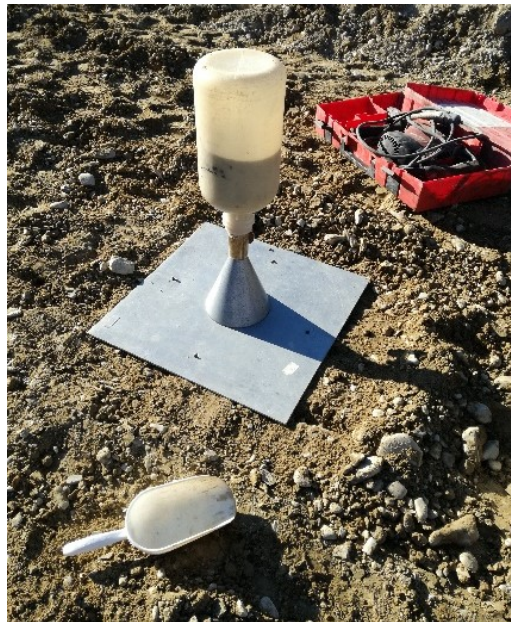
Figura 3.5: Esecuzione della prova di densità con il metodo del cono di sabbia
