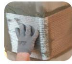
b. Tessuto in fibra di acciaio impregnato in situ in uno strato di malta di cemento
