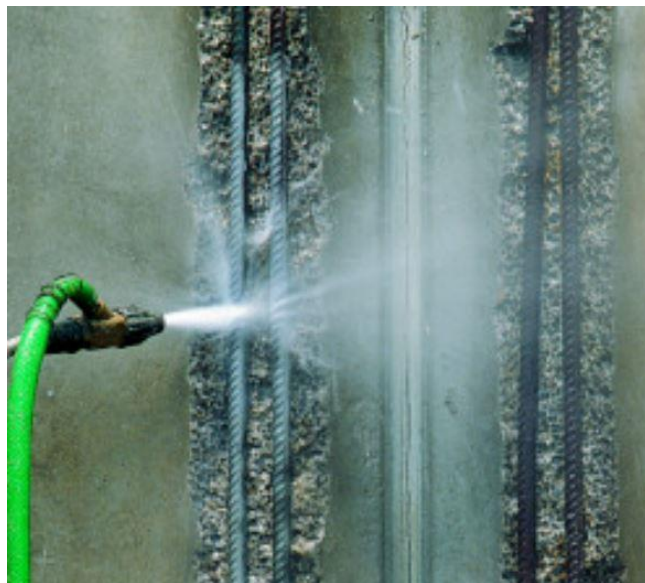
Figura 68 - Pulizia dei ferri tramite idrosabbiatura
