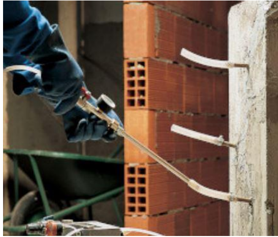
Figura 70 -Iniezione del prodotto Epojet in un pilastro lesionato (Fonte: Mapei)
