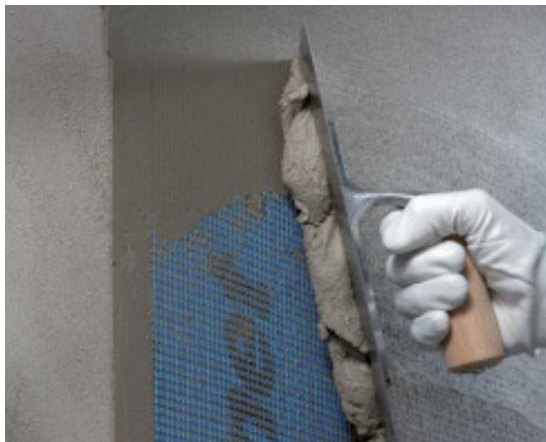
Figura 72 - Applicazione della seconda mano di Planitop 200 , con interposta Mapenet 150
