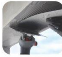
a. Impregnazione in situ con una matrice epossidica di un tessuto in fibre di acciaio
