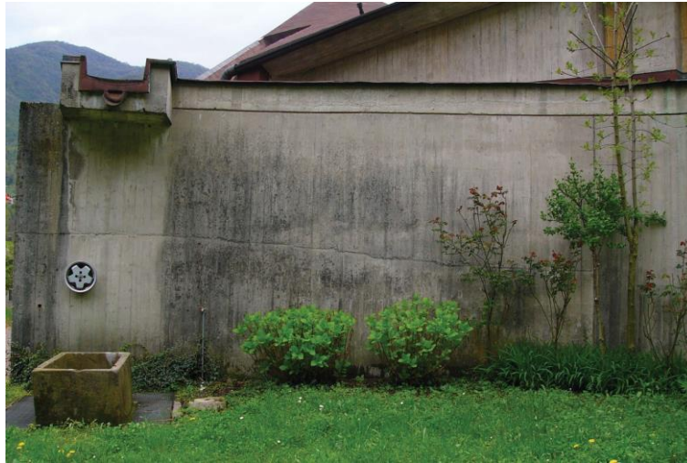
Figura 21 – Elemento caratterizzato dalla ripresa di getto
