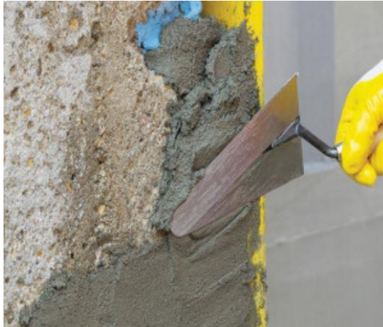
Figura 71 - Stesura di Mapegrout Ripara Facile su elemento in calcestruzzo
