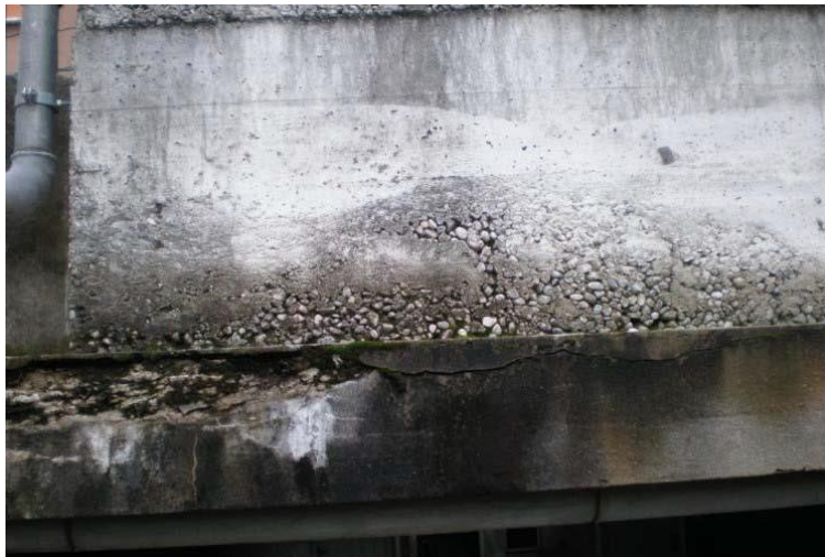
Figura 20 -Segregazione dei componenti sul fondo del getto
