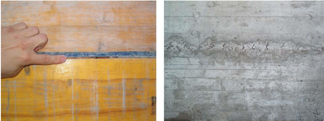
Figura 13 - Fuoriuscita della boiaccia dalle casseforme non a contatto tra loro
