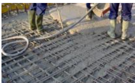
Figura 4c-Getto del giunto
