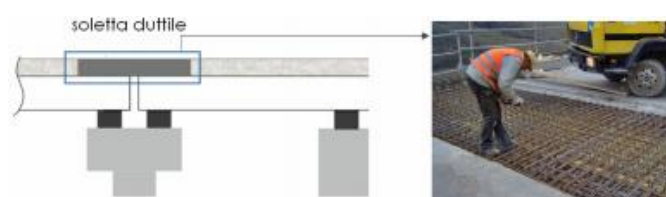
Figura 4b-Ripristino del giunto tramite solette duttili
