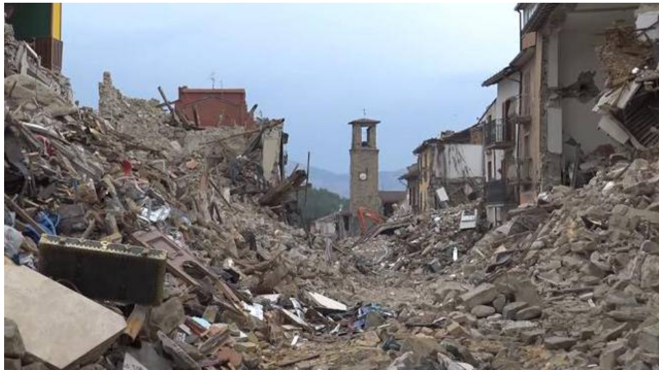
Figura 1.2: Il centro di Amatrice dopo il sisma del 24 agosto 2016
