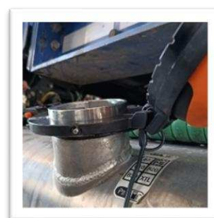
Fig. 3.1 – PROVE DI INSTALLAZIONE
