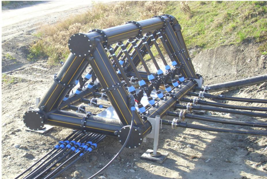
*FIGURA 8 - STAZIONE DI REGOLAZIONE E LINEE SECONDARIE DI TRAPORTO DEL BIOGAS – FONTE: “SYSTEM FOR COLLECTING BIOGAS GENERATED BY WASTE” AUTORI: M. ANTONINI, F. SANDRINI*
