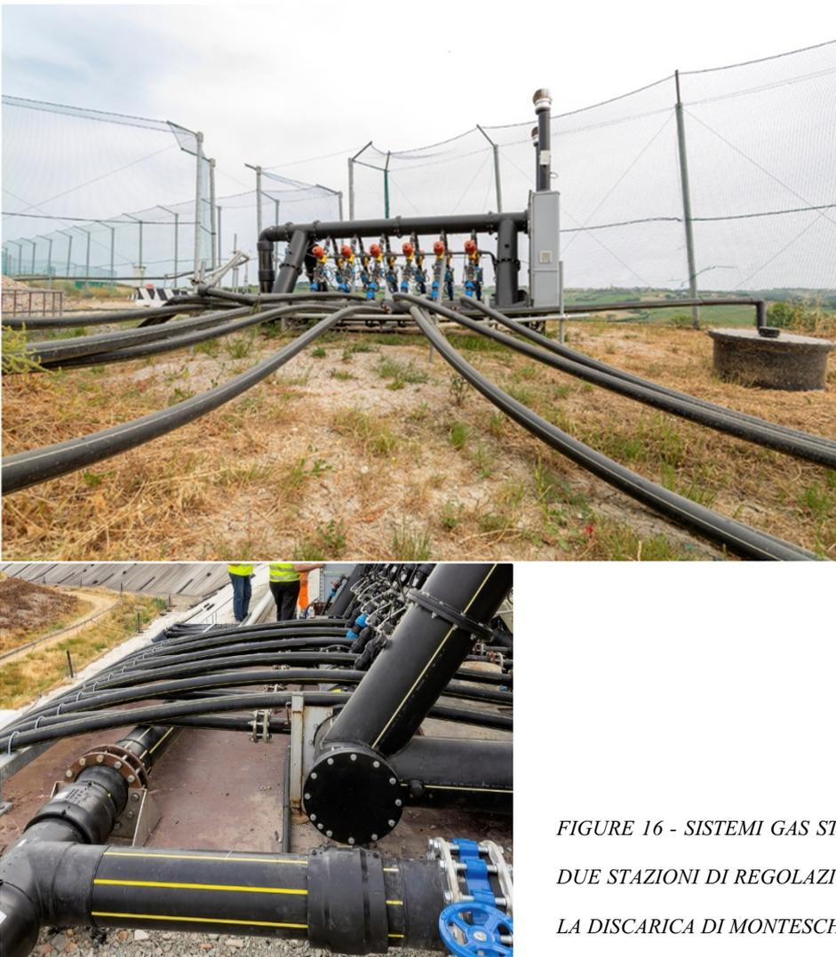
*FIGURE 16 - SISTEMI GAS STABILIZER INSTALLATI SU DUE STAZIONI DI REGOLAZIONE (SRA E SRG) PRESSO LA DISCARICA DI MONTESCHIANTELLO*
