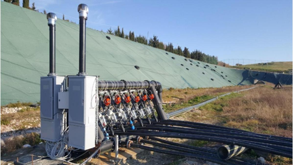
*FIGURA 1 - STAZIONE DI REGOLAZIONE CON GAS STABILIZER, DISCARICA DI MONTESCHIANTELLO – ASET SPA. FONTE: "GAS STABILIZER SYSTEM AND METHOD TO CONTROL A BIOGAS COLLECTION PLANT" AUTORI: M. ANTONINI, F.SANDRINI*
