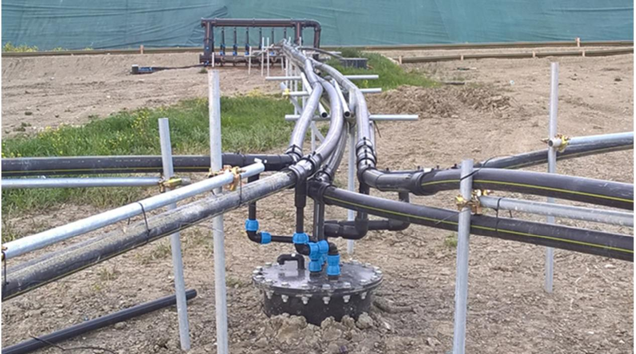
*FIGURA 7 - LINEE SECONDARIE DI TRASPORTO DEL BIOGAS. IN PRIMO PIANO UNO SCARICATORE DI CONDENZA. SULLO SFONDO UNA STAZIONE DI REGOLAZIONE – DISCARICA DI MONTESCHIANTELLO. FONTE: "SMARTENVI PROJECT - SMART DECISION TOOLS FOR REDUCING HAZARDS TO OUR ENVIRONMENT AND WATER RESOURCES BY REHABILITATING OPEN DUMPS" - ASET SPA*
