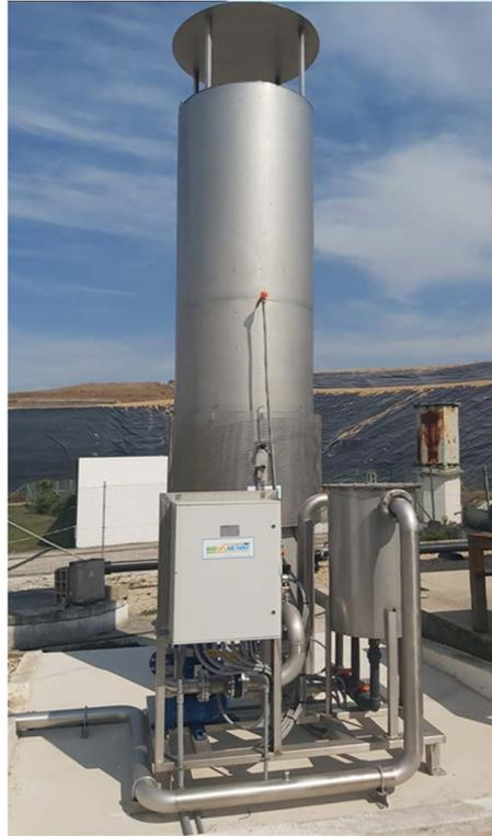
*FIGURA 12 - TORCIA AD ALTA TEMPERATURA - DISCARICA DI MONTESCHIANTELLO - FONTE:
