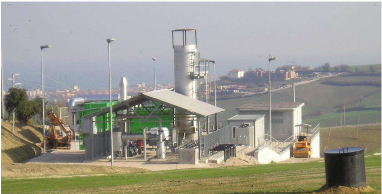
*FIGURA 11 - CENTRALE DI ESTRAZIONE E RECUPERO ENERGETICO DEL BIOGAS - DISCARICA DI MONTESCHIANTELLO -
