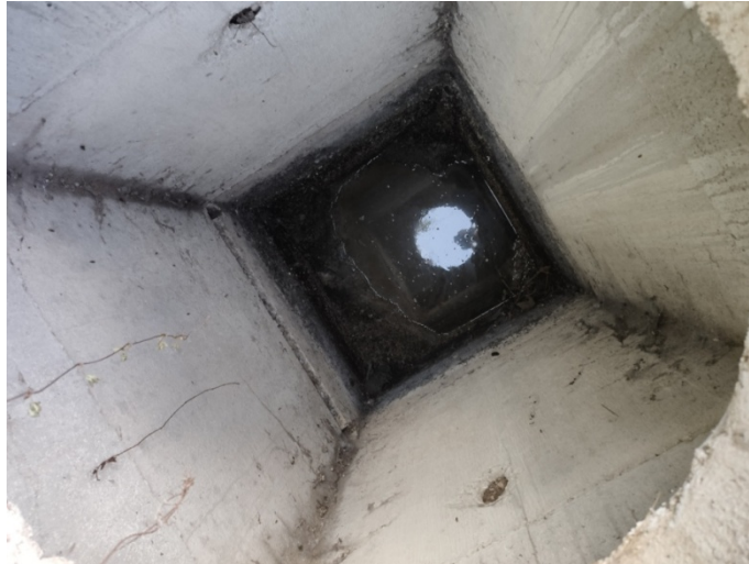
Figura 8: foto interna del pozzetto
