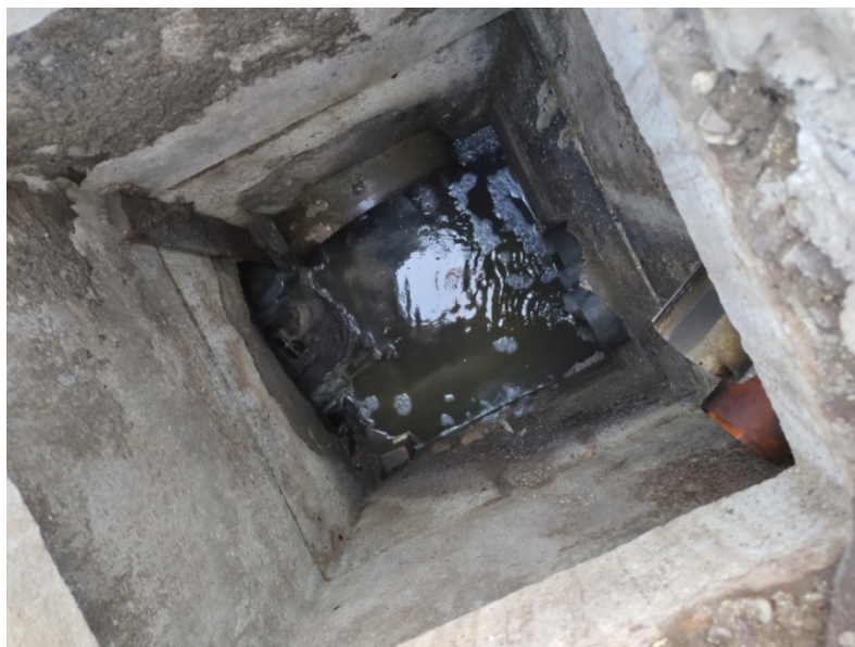
Figura 7: Foto interna del pozzetto
