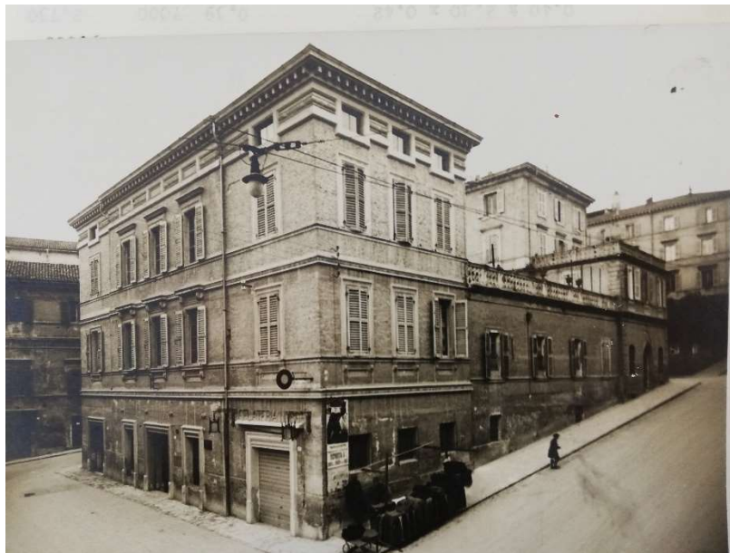
Figura 25 – Fotografia dell'edificio (fonte: archivio di Stato di Ancona, busta 124, pratica 501)
