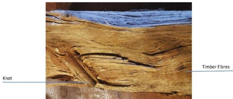
Figura 2.15 Sezione di una trave in legno che mostra l'effetti di un nodo.
