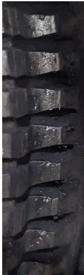
Ruota di un impianto simile con segni di pitting
