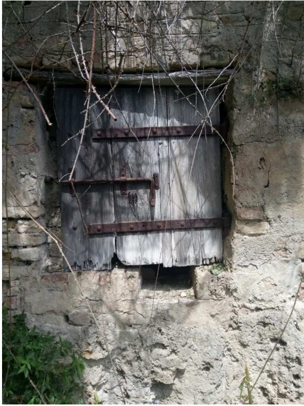
Fig. 2-1: Particolare della Fonte Piccola.
