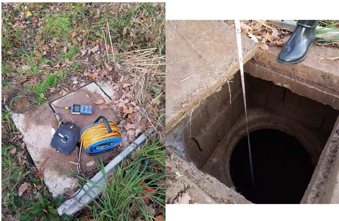
Fig. 5-7: A sinistra, cisterna (C2) chiusa con appoggiati sopra un conducimetro, una rullina metrica e un freatimetro; a destra, misura della profondità totale della cisterna (C2), mediante rullina metrica, a ovest della Fonte di Butinello.
