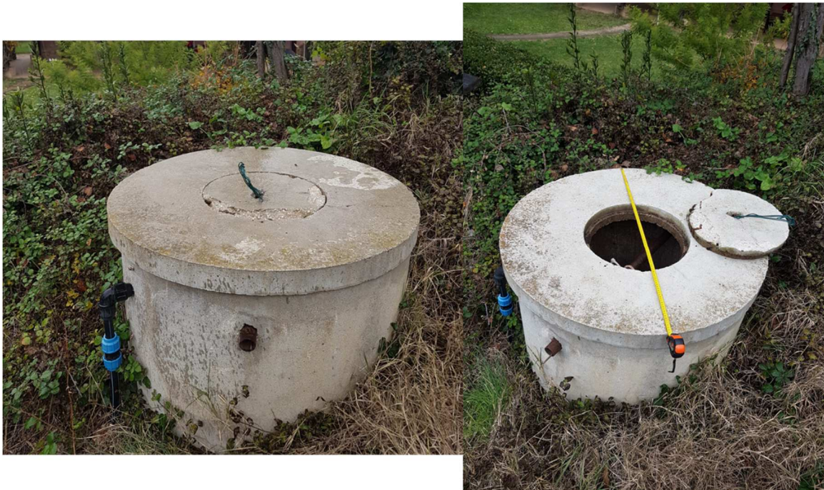
Fig. 5-3: A sinistra, secondo pozzo (P2), chiuso; a destra, secondo pozzo (P2), aperto, a nord della Fonte di Butinello, con in azione il metro per la misura del diametro della bocca del pozzo.
