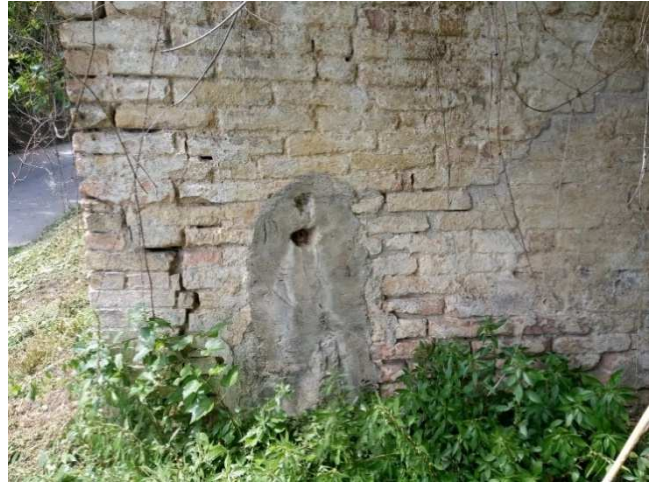
Fig. 2-2: Particolare della Fonte Piccola.
