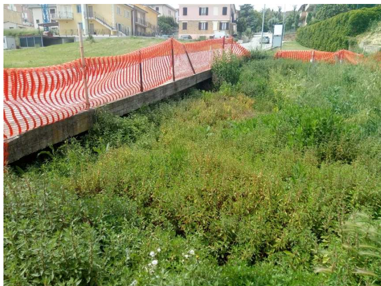
Fig. 2-16: Fonte Grande, quasi completamente interrata dopo la costruzione di una strada.
