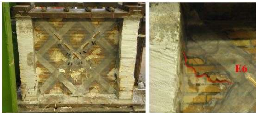
Figura 4.10 Guasto sperimentale della parete R-W2 e dettaglio della deformazione di delaminazione della striscia di GFRP.
