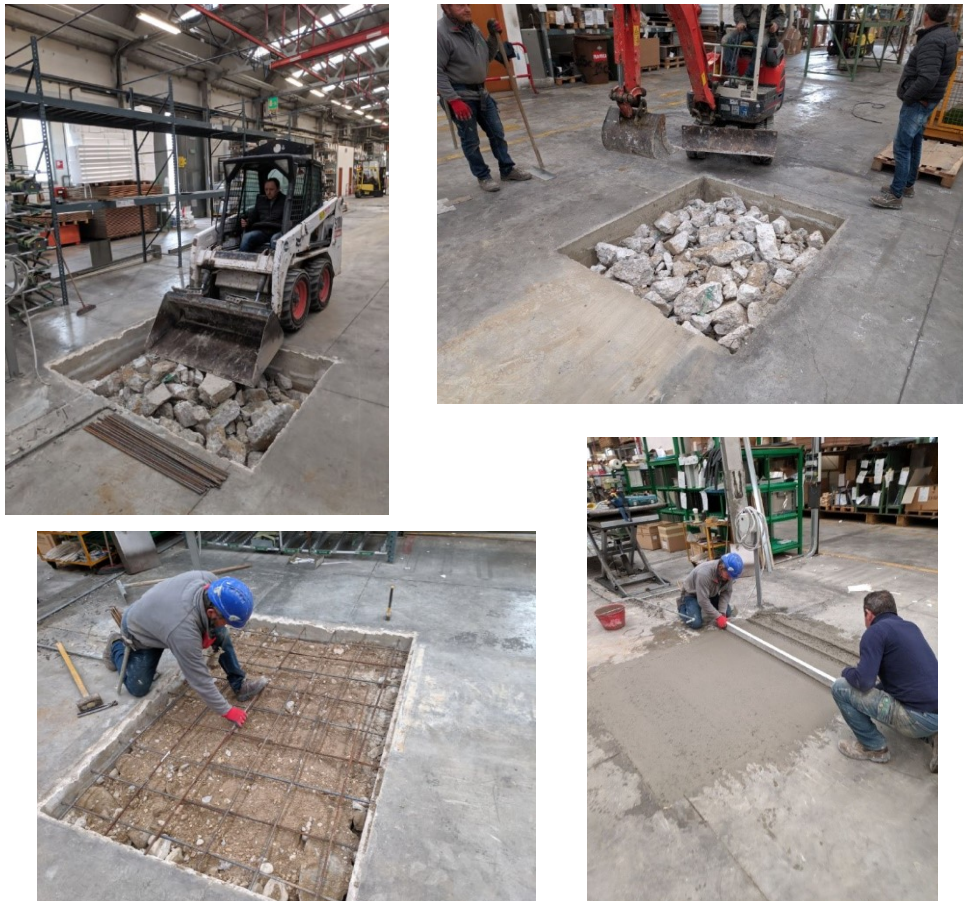
Figura 4.22 – Copertura delle buche preesistenti. Si utilizzano i ciottoli prodotti dallo scavo delle nuove buche come riempimento, dopodiché si predispongono l'armatura e si copre col cemento, che resta ad asciugare
