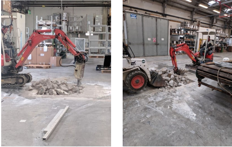
Figura 4.21 – Operazioni di scavo delle nuove buche
