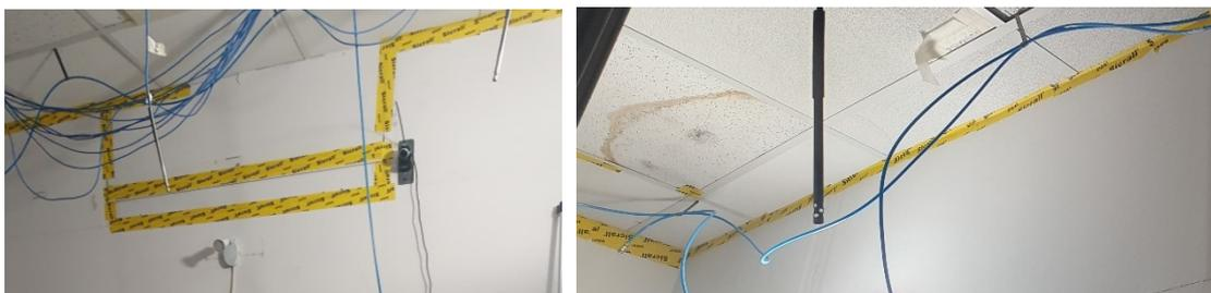
Figura 31: applicazione del nastro su intercapedini e fessure
