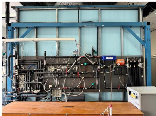
*Figura 29: impianto idraulico per pannelli radianti*
