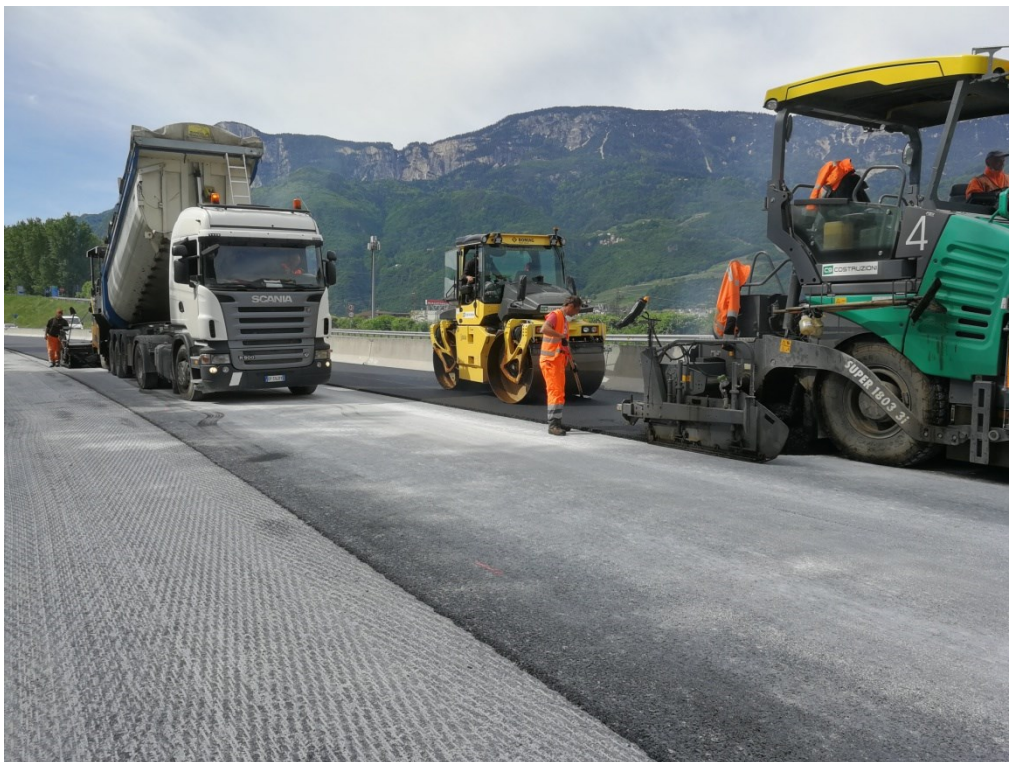
Figura 35 - Stesa dello strato di usura (no emissioni)
