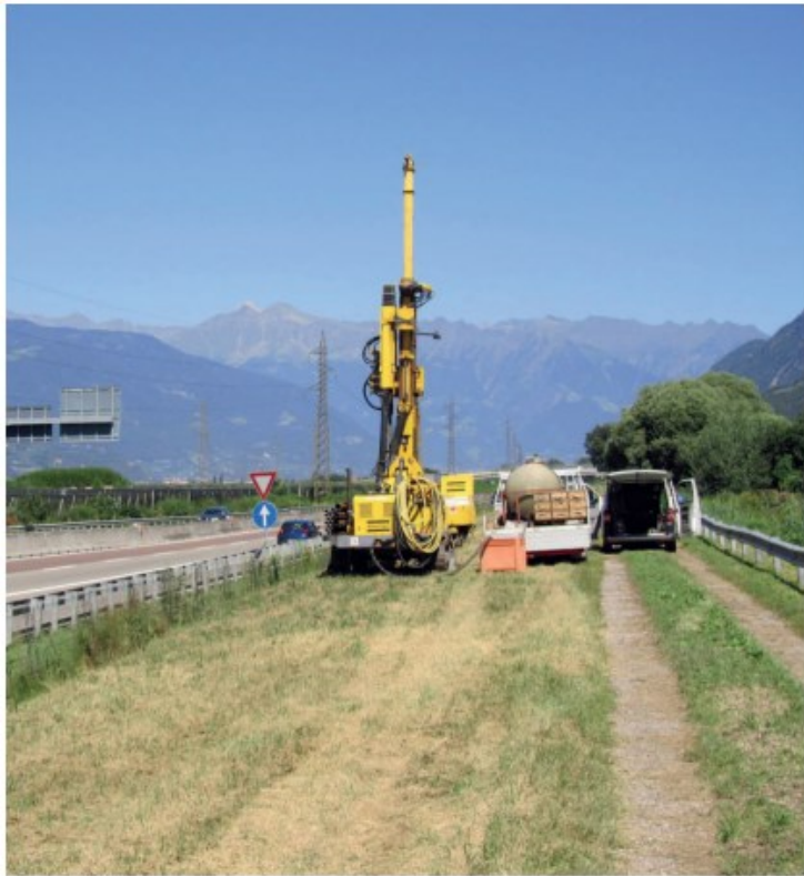
Figura 2 - Esecuzione dei sondaggi
