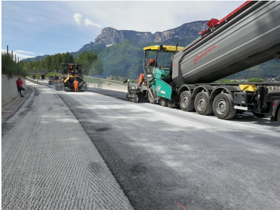
Figura 34 - Stesa strato di usura con polverino di gomma con 2 finitrici affiancate
