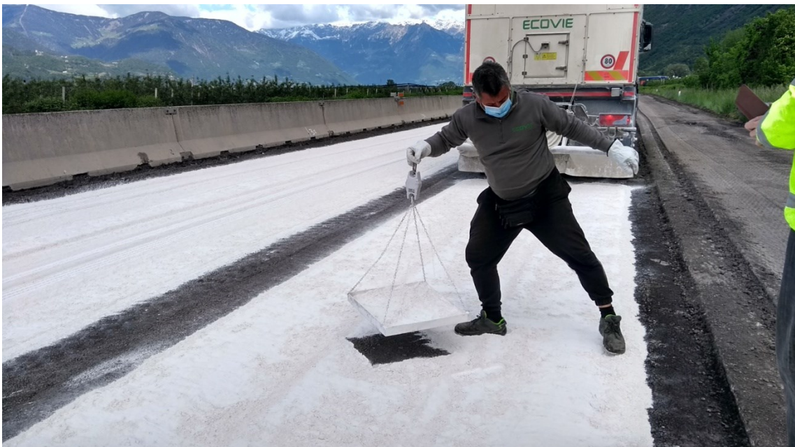
Figura 27 - Spandimento della calce
