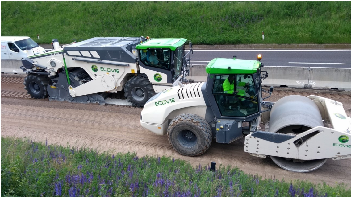
Figura 30 - Passaggio di rullo per compattazione
