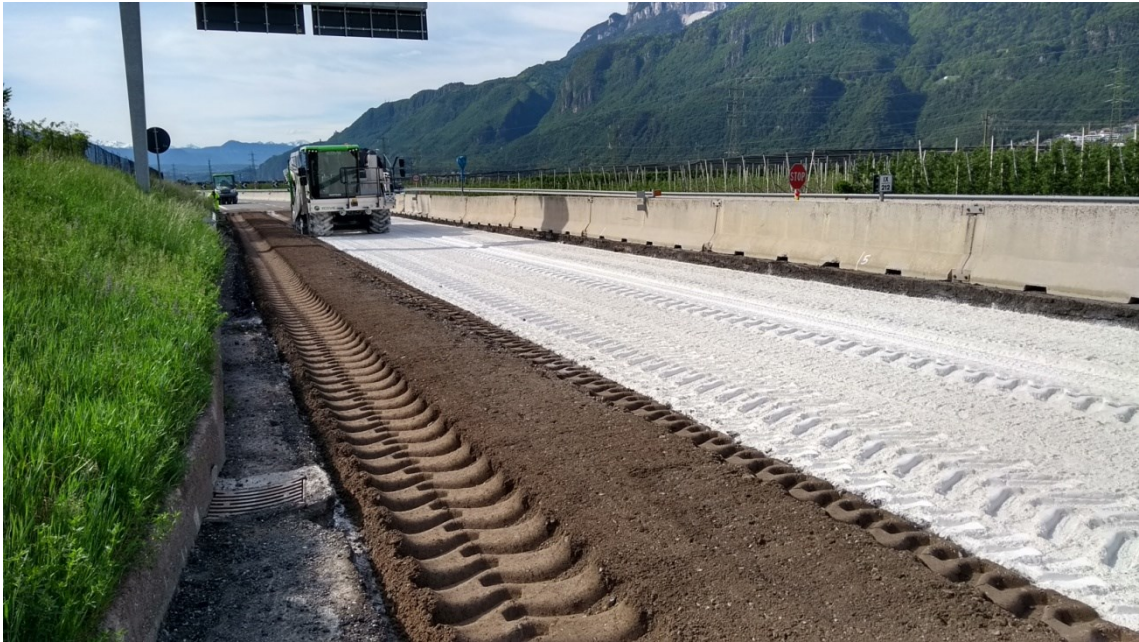
Figura 28 - macchina stabilizzatrice in azione
