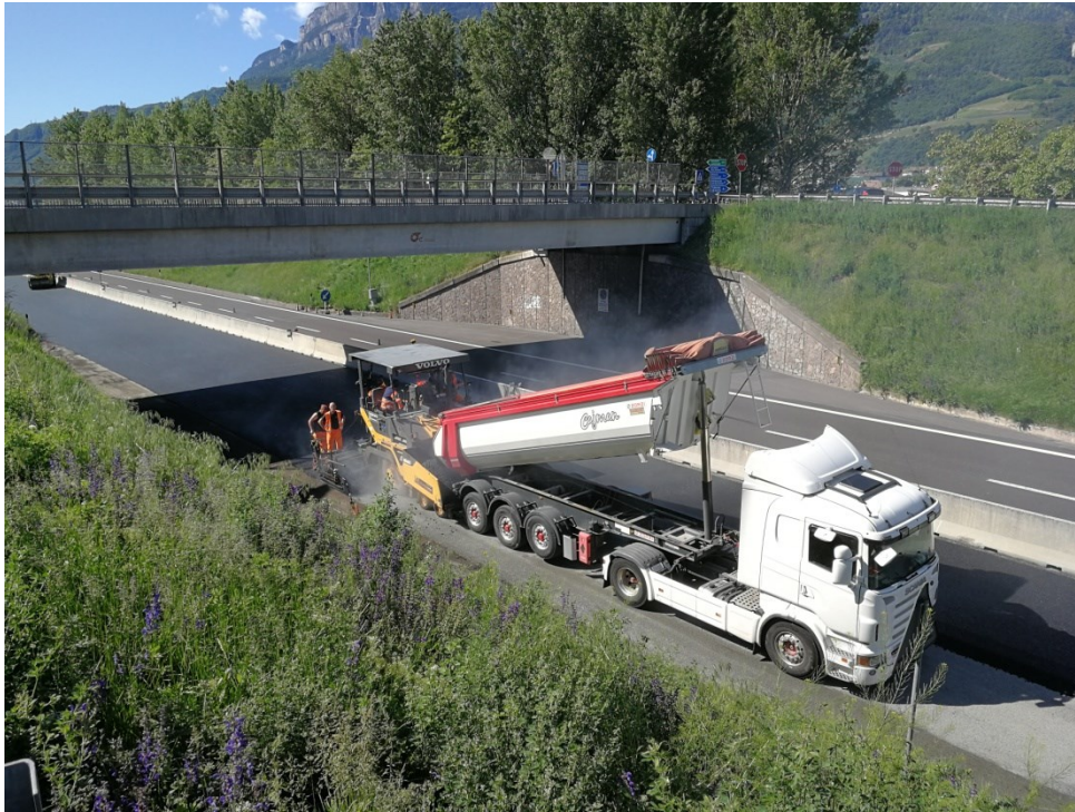
Figura 32 - Stesa dello strato di base
