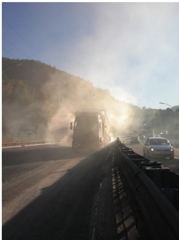
Figura 22 - Emissione di fumi con la metodologia Wet
