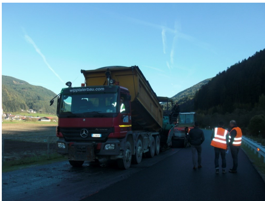
Figura 24 - Stesa del conglomerato senza emissione di fumi (tecnologia Dry)
