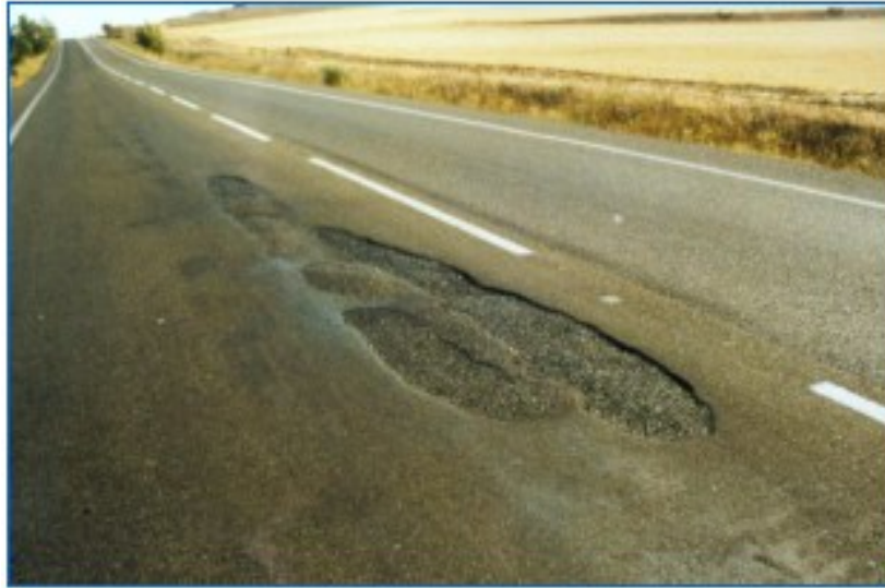
Figura 23 - Problematiche del metodo Dry
