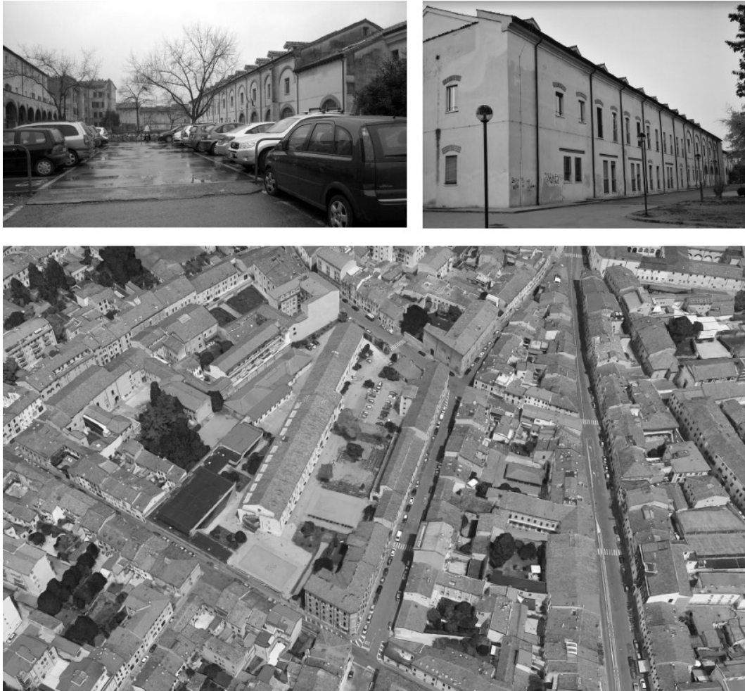
Figura 9 - Scuole Sacchi e Ardigò: esterni e vista aerea
