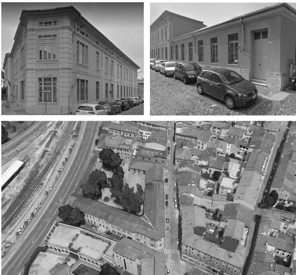
Figura 4 – Scuola Primaria Pomponazzo: esterni e vista aerea
