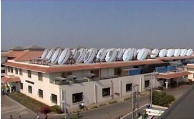
Figura 53: Muni Serva Ashram ha convertito il suo sistema di cottura solare Scheffler basato sul vapore per utilizzare il fluido termico per essere in grado di fornire la cottura notturna
