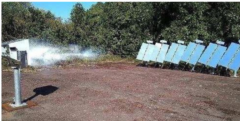
Figura 76: Torrefazione solare 'Puro Sole'
