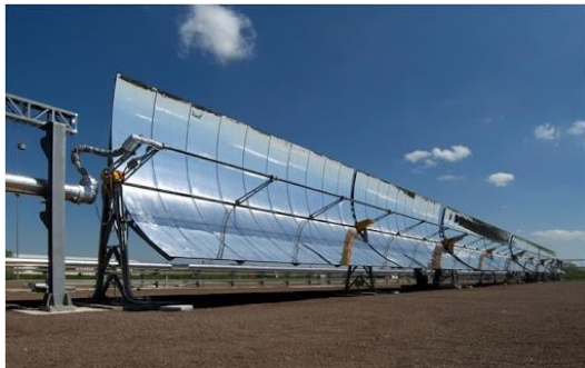
Collettore parabolico lineare
