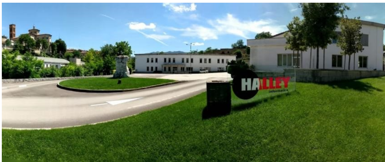
Figura 4 Stabilimento Halley informatica
