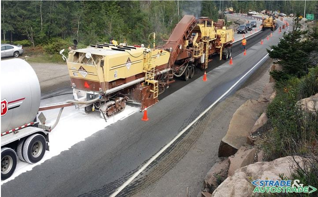
Figura 0.2 – Esecuzione dell'riciclaggio a freddo
