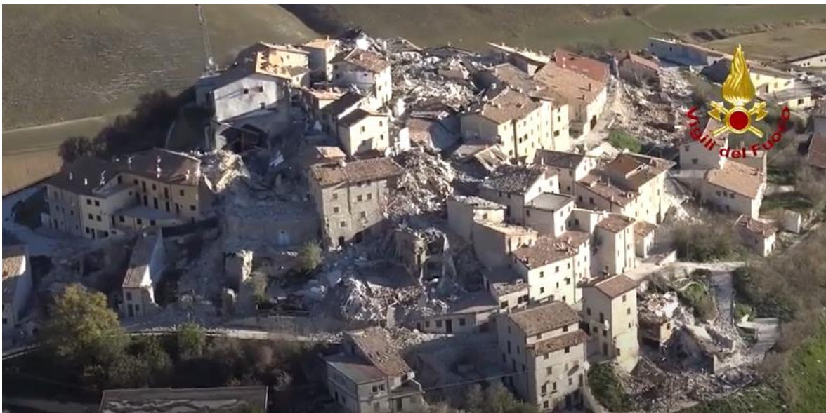
Figura 48_Castelluccio post sisma 2016 (immagini Vigili Del Fuoco)
