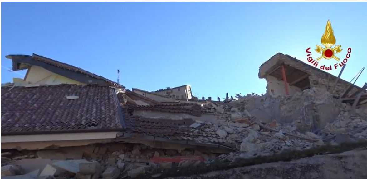
Figura 50_Castelluccio post sisma (Vigili del Fuoco)
