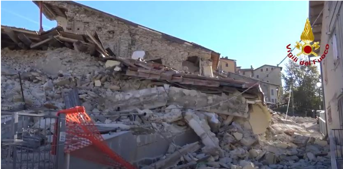
Figura 49_Castelluccio post sisma 2016 (Vigili del Fuoco)
