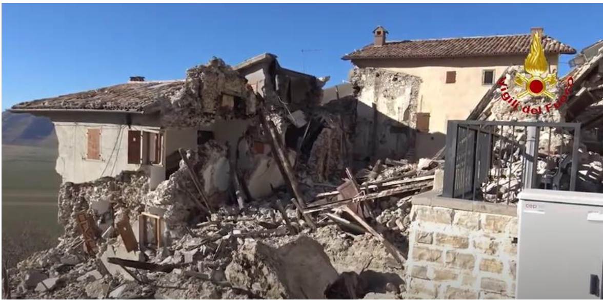
Figura 52_Castelluccio post sisma (Vigili del Fuoco)
