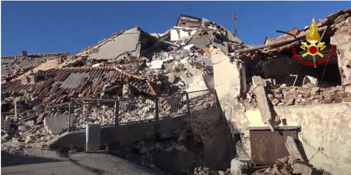
Figura 51_Castelluccio post sisma (Vigili del Fuoco)
