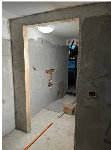
Figura 2: Nuova partizione interna completa di vano per infisso (porta).
