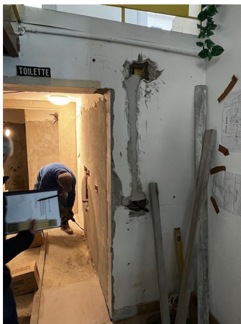
Figura 7: Tracce per impianto elettrico.
