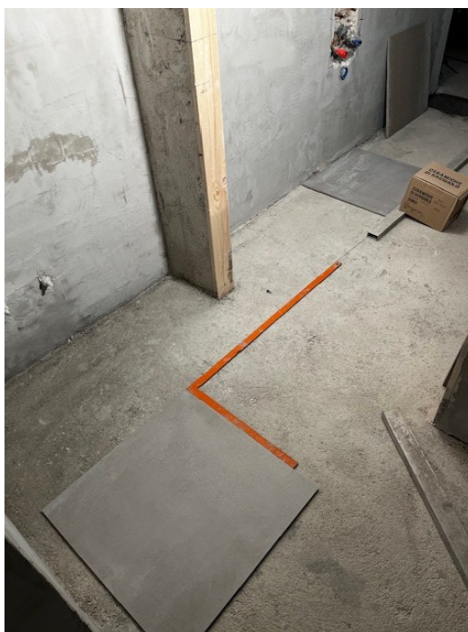
Figura 3: Posa in opera delle piastrelle per la pavimentazione del locale bagno.
