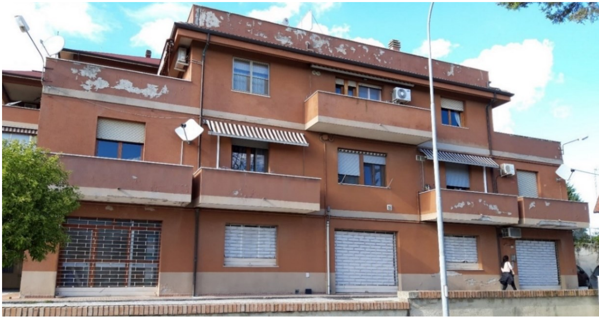
Figura 1 – Vista esterna fabbricato 1
