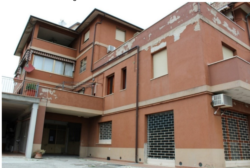
Figura 2 – Vista esterna fabbricato 2
