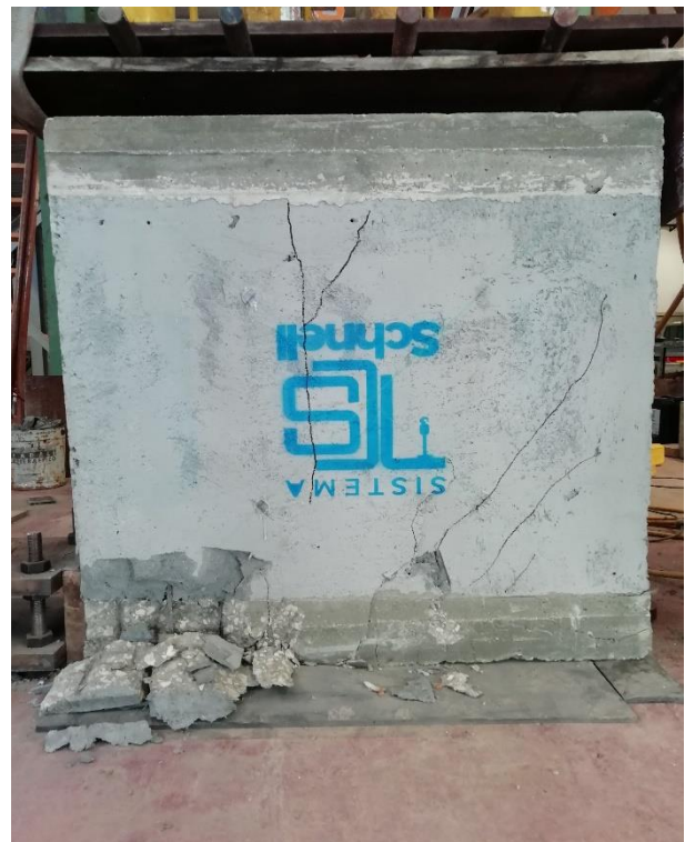
Figura 6.29 - Fessurazione diagonale e schiacciamento spigolo fronte PT2
