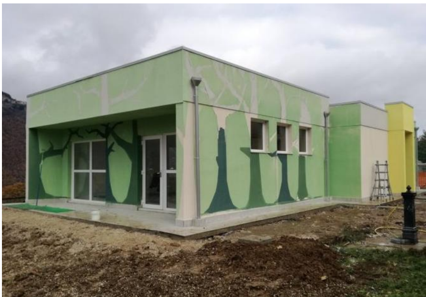
Figura 2.1 – Esempio di edilizia scolastica realizzata con pannelli sandwich strutturali, Acquisanta Terme (AP)
