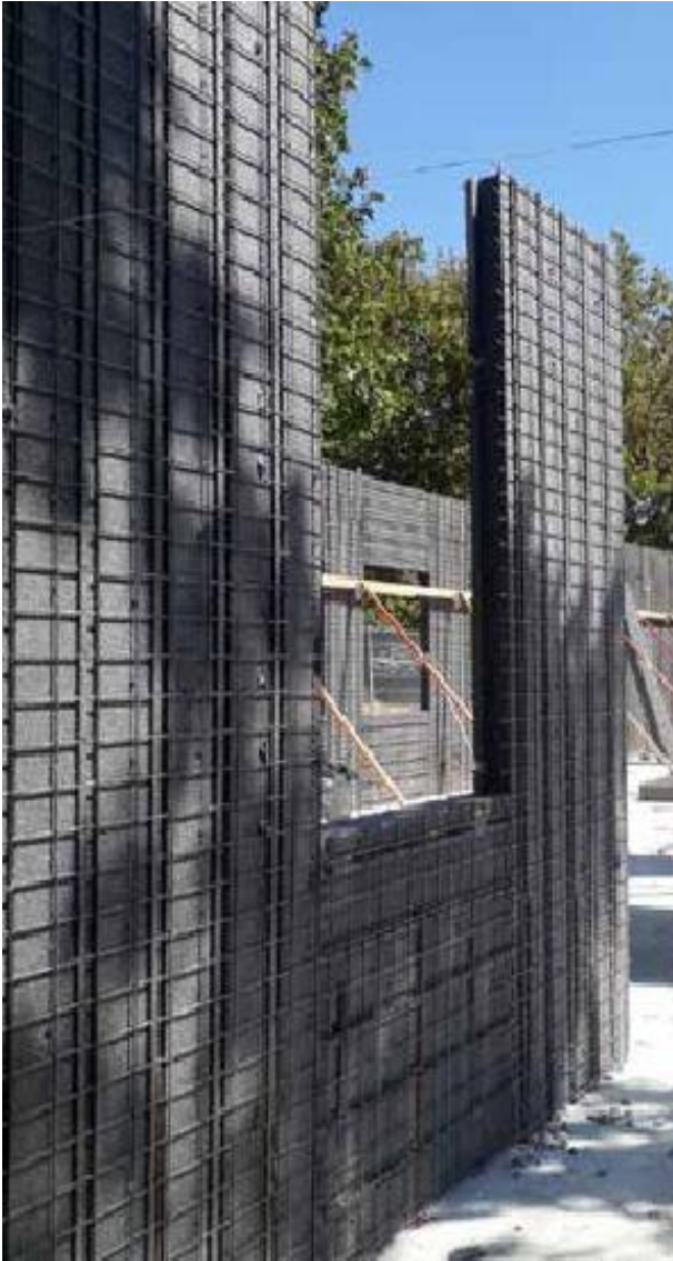
Figura 3.4 – Fasi di cantiere – montaggio del pannello di supporto in EPS rinforzato e successiva fase di getto con calcestruzzo a spruzzo
