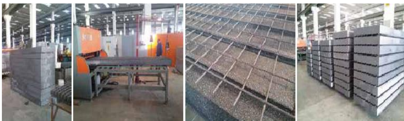
Figura 3.3 – Fasi di produzione del pannello di supporto in EPS
