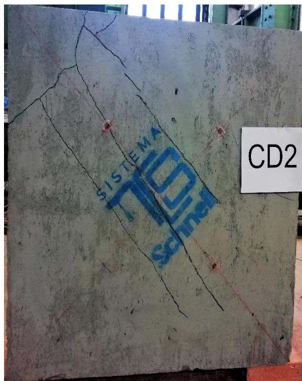
Figura 6.5 - Fessurazione diagonale CD2
