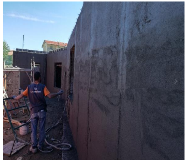
Figura 3.4 – Fasi di cantiere – montaggio del pannello di supporto in EPS rinforzato e successiva fase di getto con calcestruzzo a spruzzo
