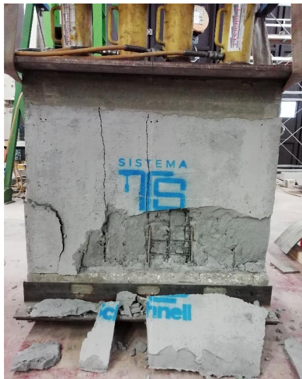
Figura 6.21 - Schiacciamento e fessurazione verticale retro CE2
