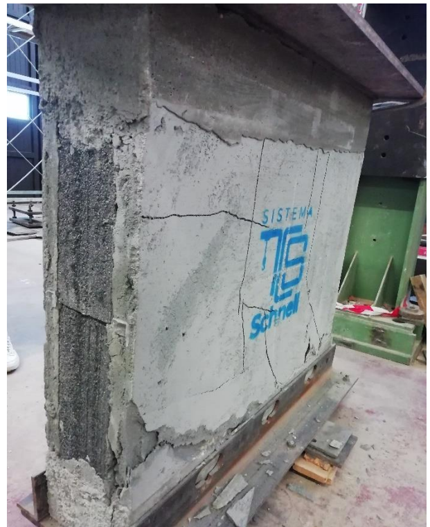
Figura 6.23 - Fessurazione verticale retro e schiacciamento CE4
