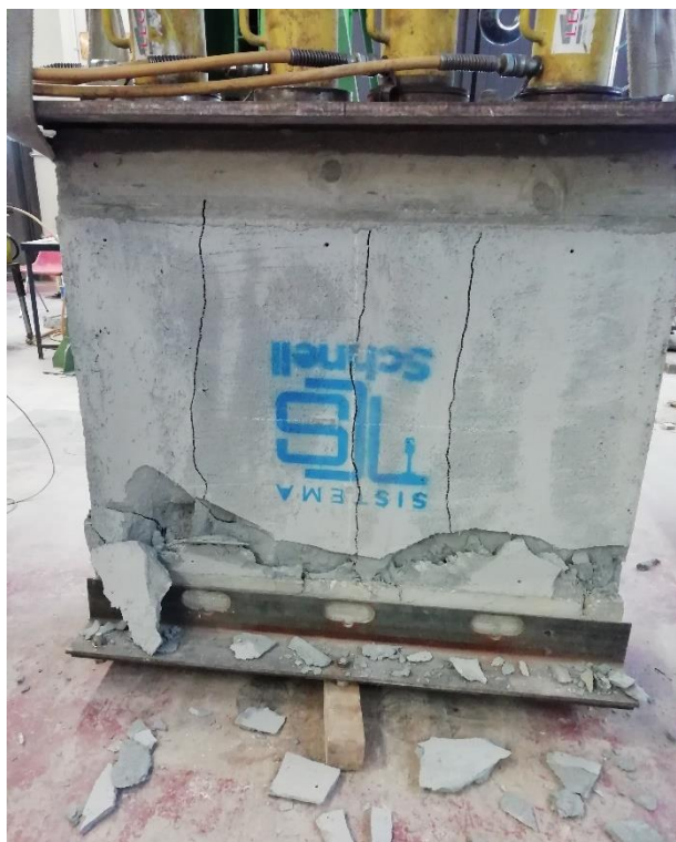
Figura 6.20 - Schiacciamento e fessurazione verticale retro CE1
