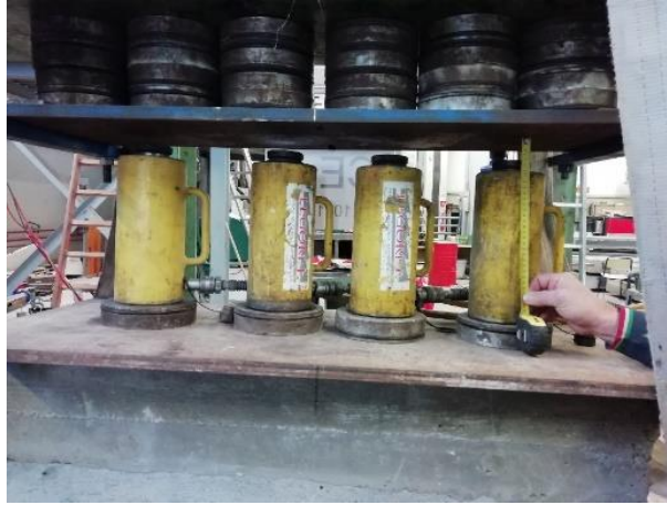
Figura 5.5 – Irregolarità costruttiva del pannello CE4 rilevata tramite eccessiva distanza ultimo martinetto-piastra di appoggio
