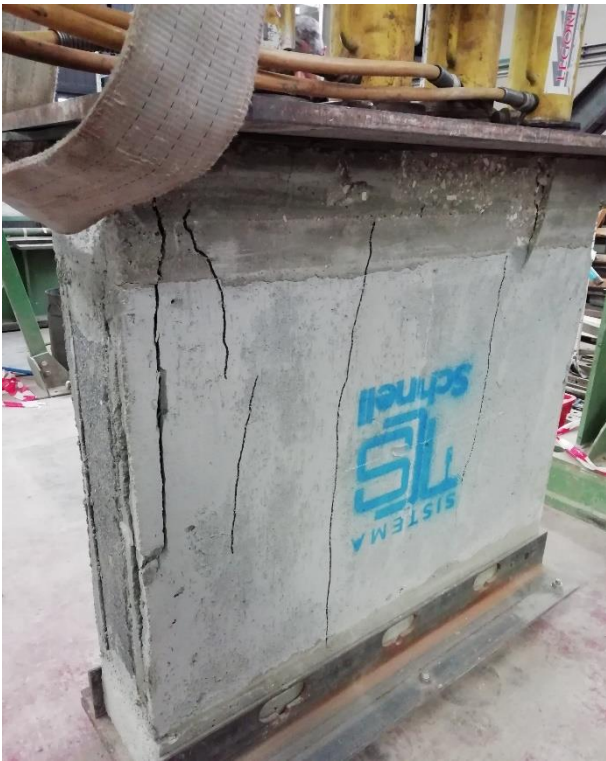
Figura 6.22 - Fessurazione verticale retro CE3
