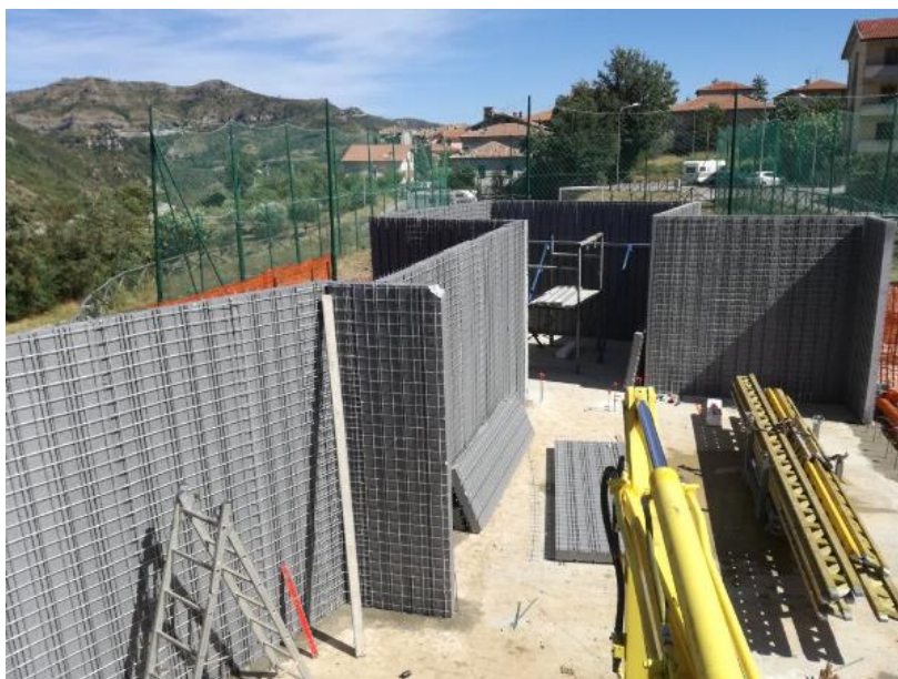
Figura 2.3 – Pareti strutturali realizzate con pannelli sandwich
