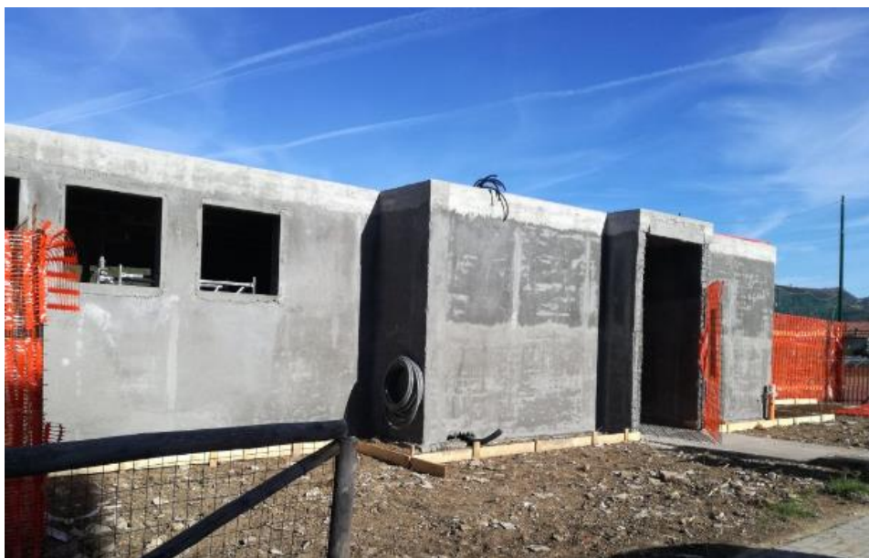
Figura 3.5 – Fasi di cantiere – risultato finale di struttura a pannelli sandwich
