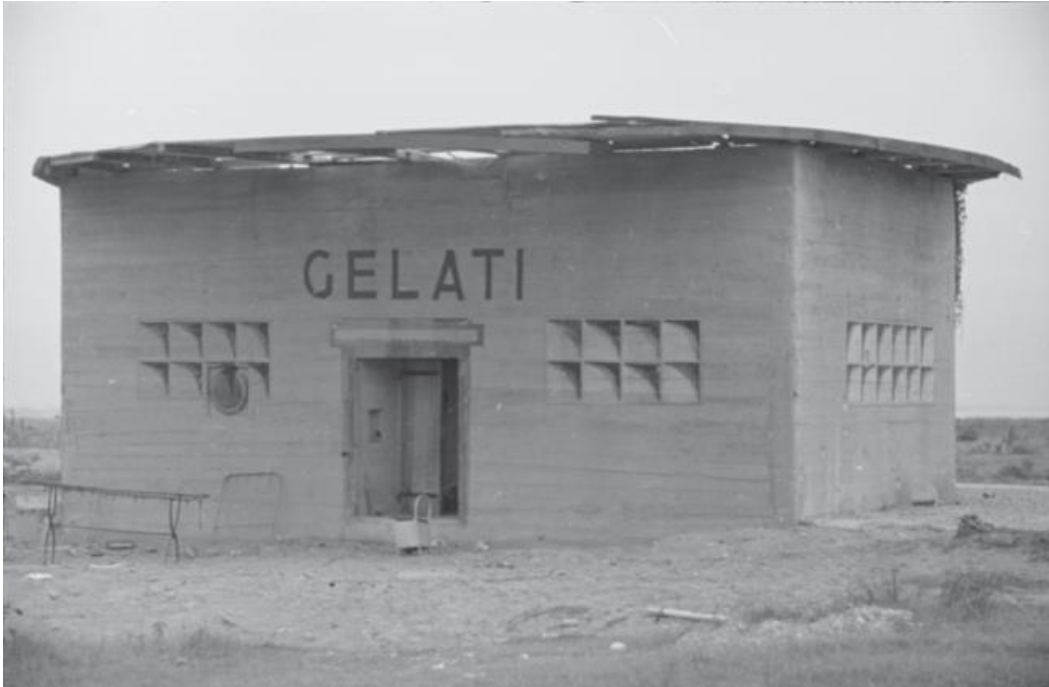
Figura 21_ Dintorni di Rimini, bunker mascherato attraverso la dipintura di porte, finestre e di un'insegna "gelati". "I bunker tedeschi a difesa della Linea Galla Placidia. Conservare un patrimonio dimenticato". pag. 174 Mariotti, Ugolini, Zampini
