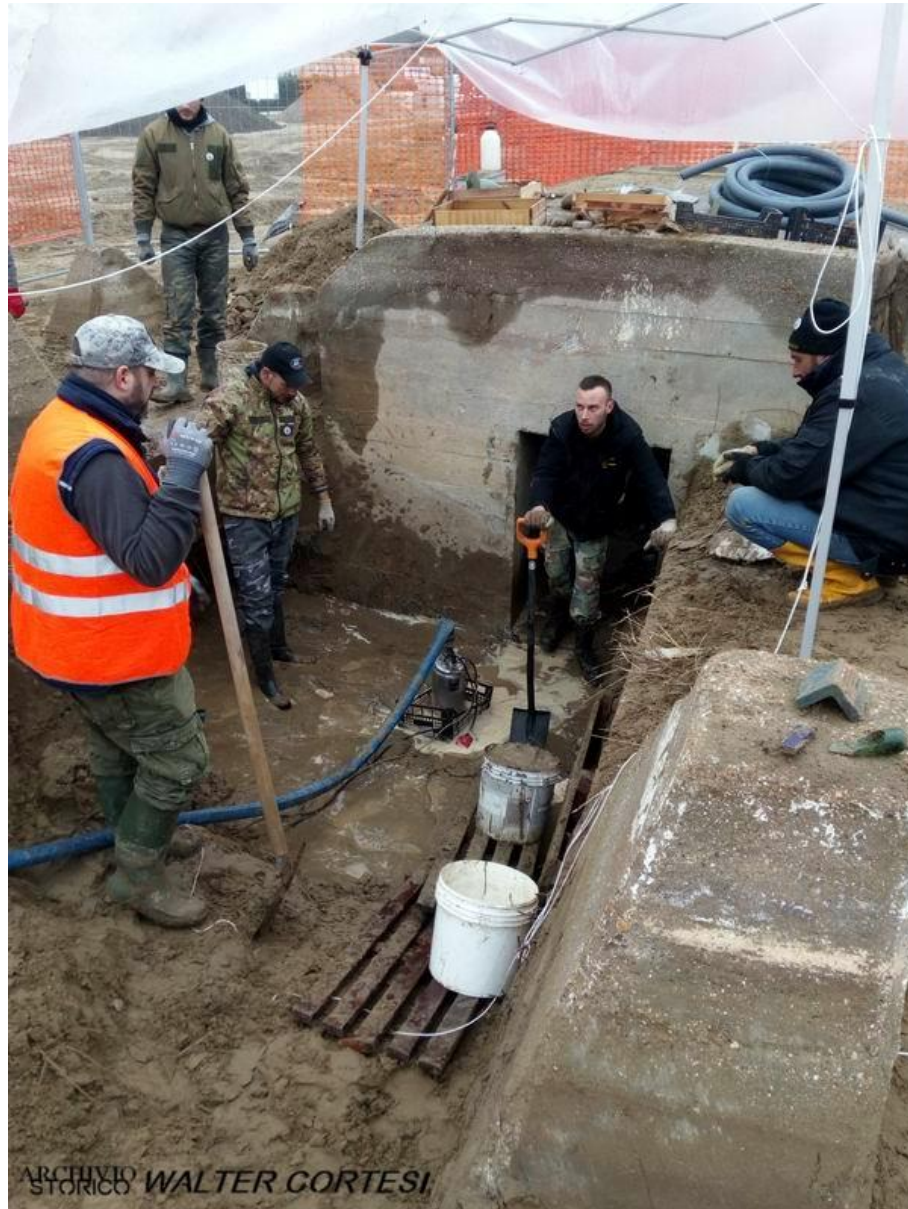
Figura 30_Esecuzione dello scavo bunker a opera del CRB360° a Milano marittima. https://crb360ets.it/il-restauro/
