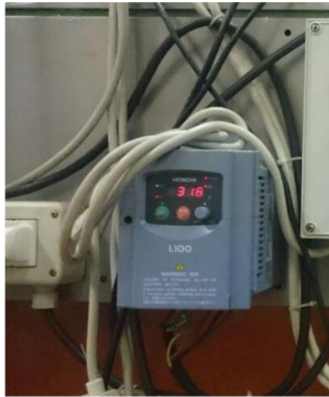
Fig.3.7 Inverter per la regolazione del numero di giri
