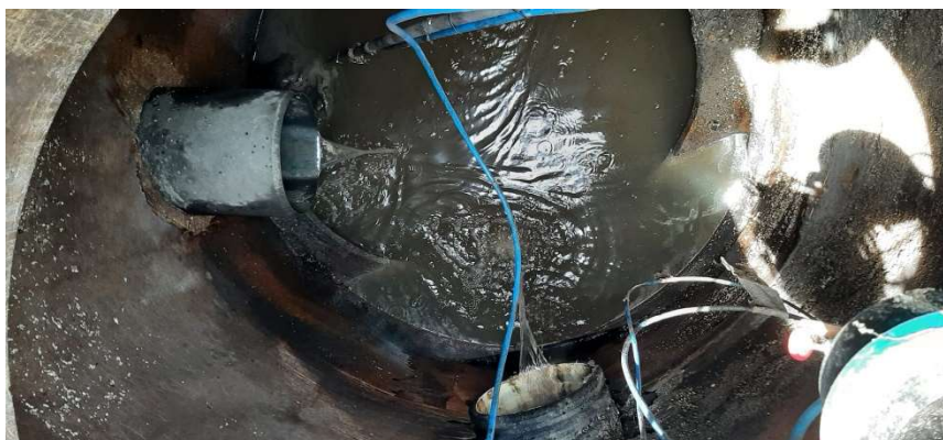
Figura 61 esempio di misure nel pozzetto POZF100127 (a valle di IS4)
