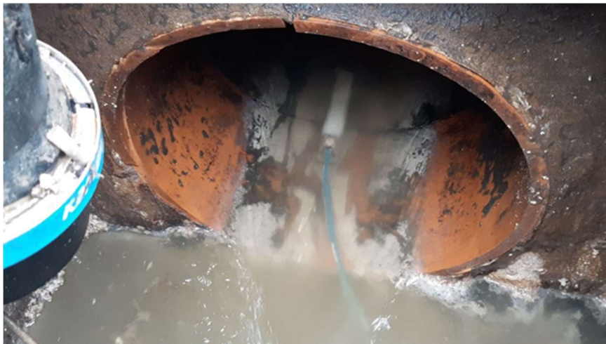
Figura 53 Esempio di installazione (Kaptor "ALBULA DX")
