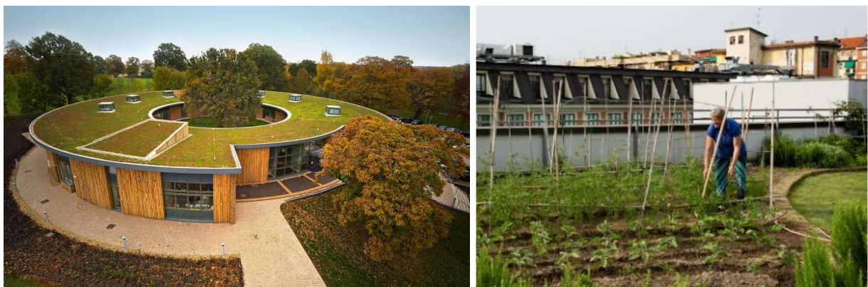
Figura 14 esempio di tetto verde estensivo ed intensivo
