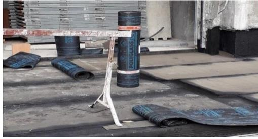
Figura 6: Impermeabilizzazione con guaina bituminosa
