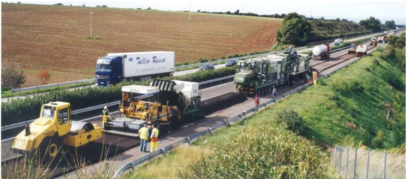
Figura 9 Treno di riciclaggio
