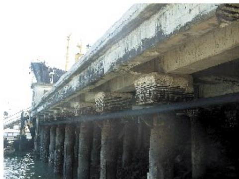
**Figura 3.4.1.1** - *Corrosione dei ferri nelle zone esposte agli spruzzi dell'acqua*
