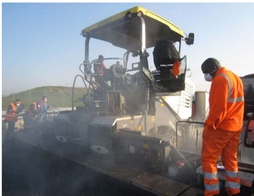
Fig.8. Evaporazione durante la fase di posa.
