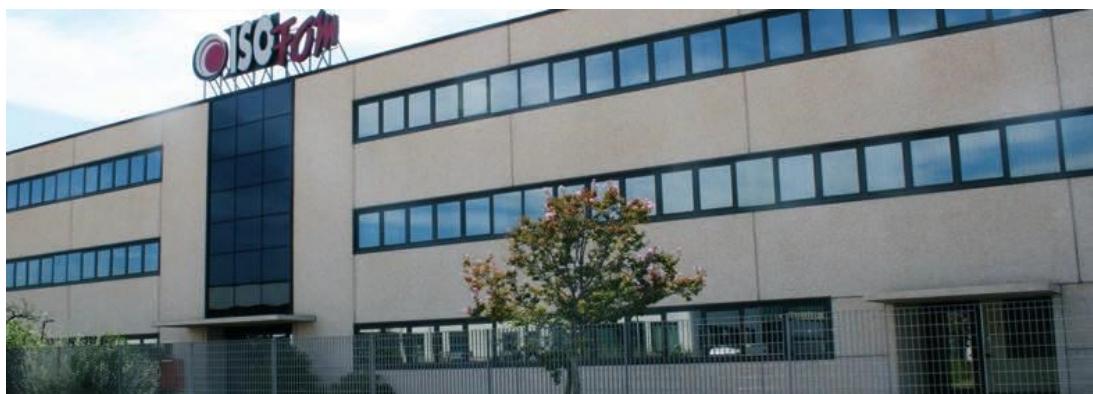
Figura 13 – Stabilimento Isofom (PU)
