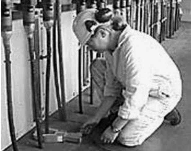
[15] Trasformatori di corrente "clip-on" applicati sui cavi di alimentazione
