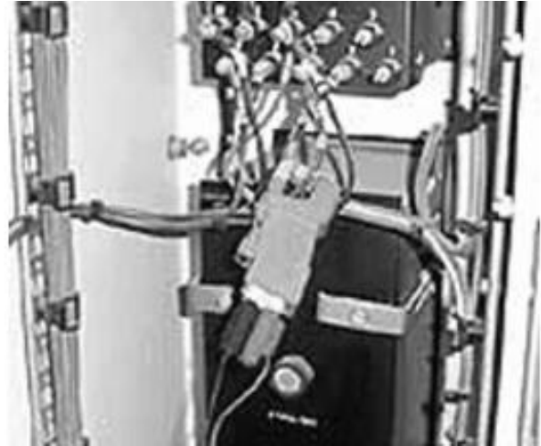
[15] Trasformatori di corrente "clip-on" applicati sui cavi di alimentazione
