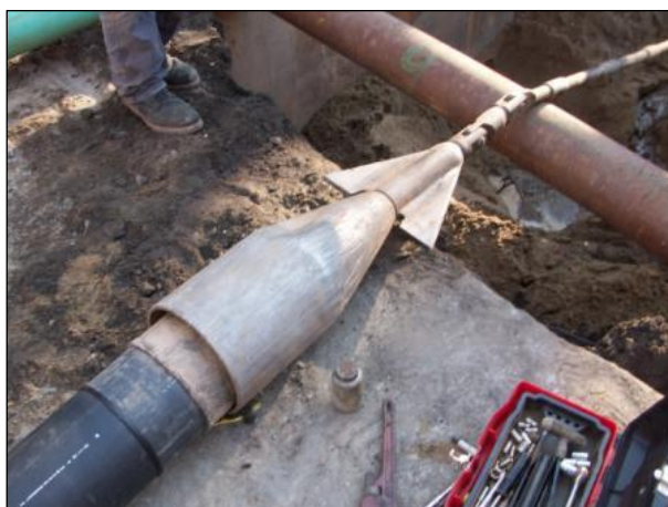
Figura 112 Tipo di testa e relativo aggancio utilizzati nel Pipe Spitting. https://ucononline.com/magazine/2011/june-2011-vol-66-no-6/features/pipe-bursting-various-types-of-pipes .
