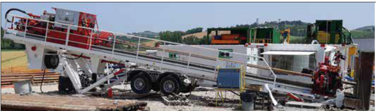
Figura 110 Unità di perforazione "Rig". Fonte: Snam.
