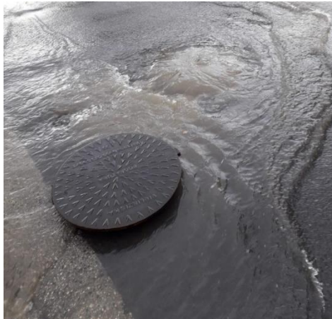
Figura 88 Tombino scoperchiato causato dalla forte pressione, in concomitanza di un cospicuo evento piovoso in Siracusa. Fonte: Oranews.
