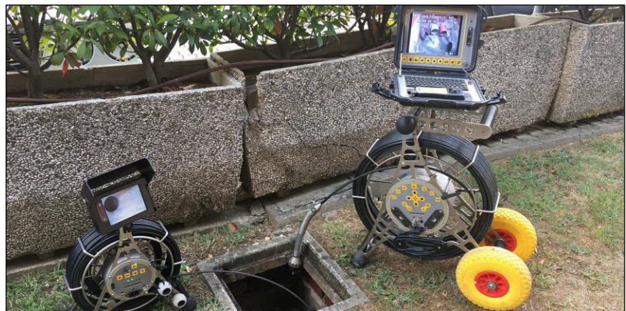
Figura 97 Apparecchiature mobili, acquisizione dati e bobine durante un'ispezione con telecamera in una tubazione fognaria. Fonte: Ecobatti.
