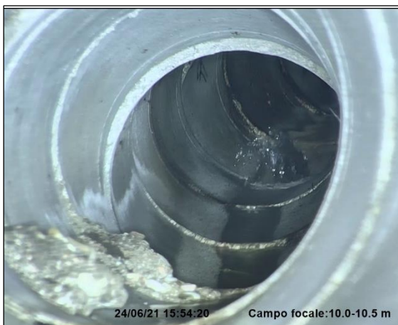
Figura 98 Infiltrazione parassita nella rete fognaria di Tolentino. Materiale fotografico proveniente dall'indagine nella campagna di misura del 24/06/2021. Fonte: Soc. Hydro-ingegneria.
