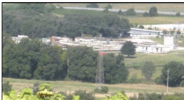
Figura 2 Impianto di depurazione di Tolentino. Fonte: ASSM S.p.a.
