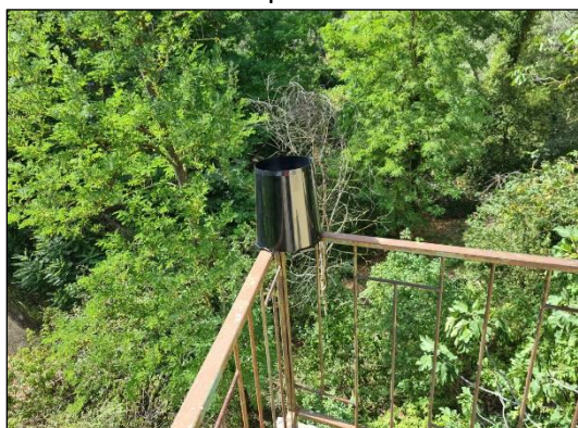
Figura 137 Installazione del pluviometro in Viale Cappuccini n°11. Fonte: Hydro Ingegneria.
