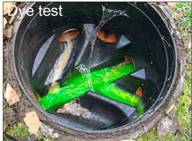
Figura 94 Test del colorante fluorescente dove si va a verificare l'effettivo collegamento tra la zona sospetta e un punto di ispezione della rete. Fonte: Fast Ambiente Academy.
