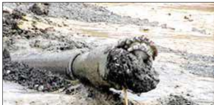
Figura 113 Fine della perforazione con fuoriuscita della trivella/tricono. Fonte: Snam.
