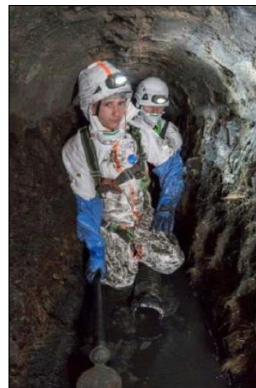
Figura 92 Tunnel sotterraneo ispezionabile. Fonte: Fast Ambiente Academy.
