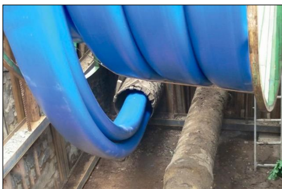
Figura 119 Fase di posa: srotolamento dalla bobina e successivo inserimento nel tubo da risanare per la nuova sezione "predeformata". Fonte: https://benassisrl.com/risanamento-condotte/slip-lining/ .
