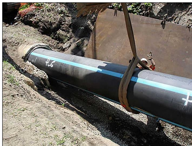
Figura 116 Fase d'inserimento per una condotta principale in Treia (MC). Fonte: https://northseaproject.com/index.php/slip-close-fit-lining .
