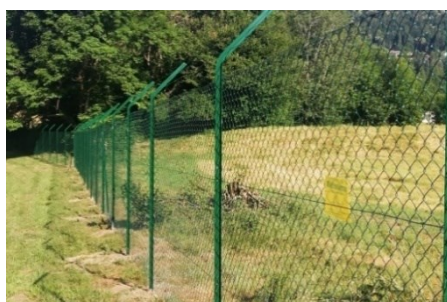
Figura 7-14 esempio di recinzione mista ( https://www.retissima.it/recinzione-antiscavalco-cosa-sapere/ )
